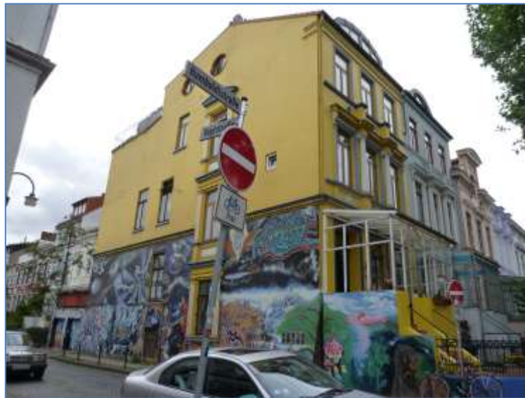
Figura 10. Fachada lateral de residência multi-familiar, Humboldtstrasse, Bremen, Alemanha (setembro de 2010)
