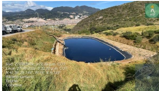
Fuente: UAESP visitas de campo 27 de septiembre de 2022.
