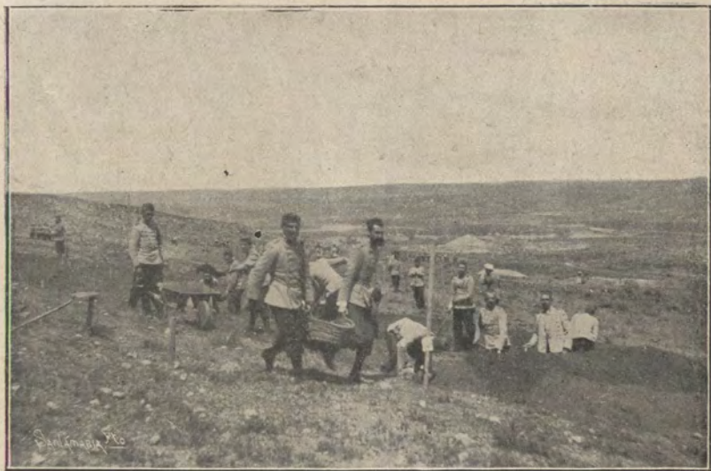
Construcción de una batería para dos piezas.
