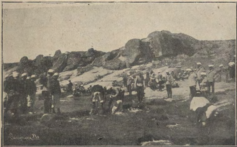
Reconstrucción de la pasadera del Torcoç.
