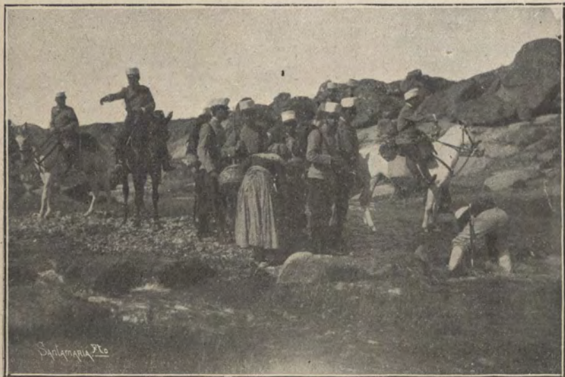
Construyendo una pasadera en el arroyo Torcoñ.
