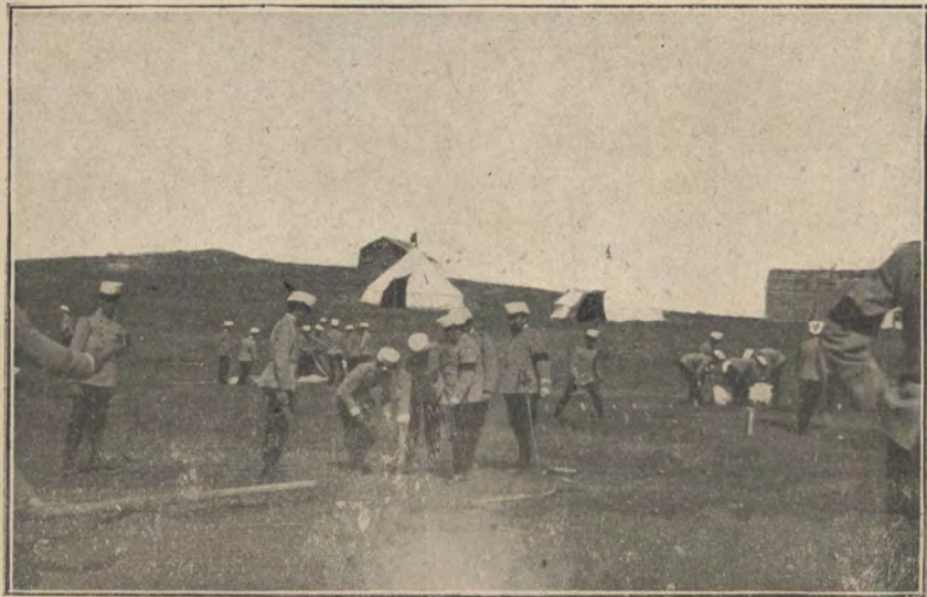
Instalación de tiendas en el Campamento.
