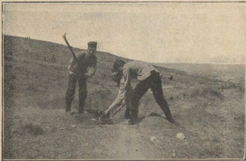
Construcción de un pozo de tirador.
