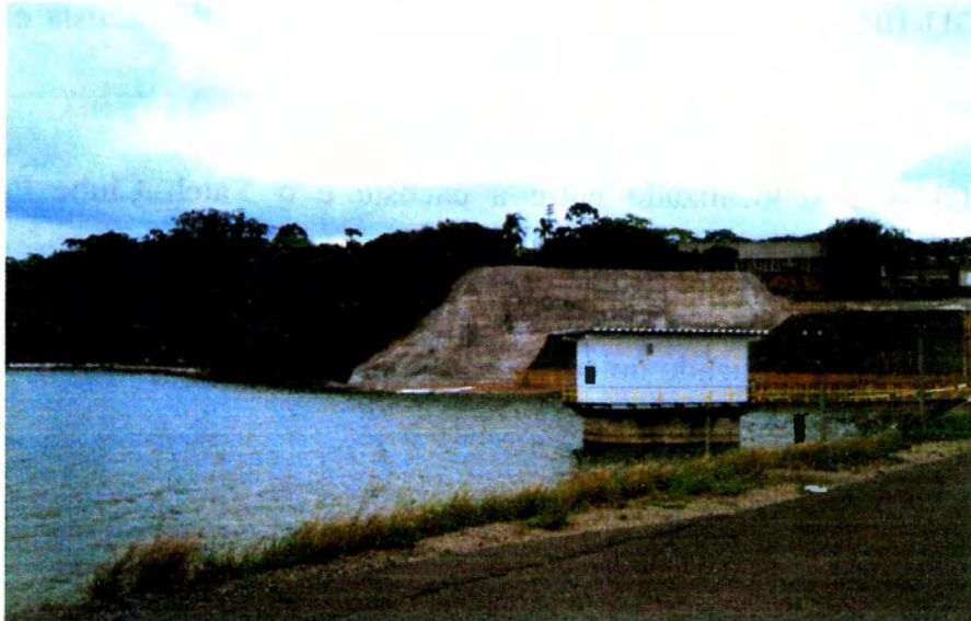
Figura 13 – Ponto de captação de água da SABESP no Reservatório de Guarapiranga.
