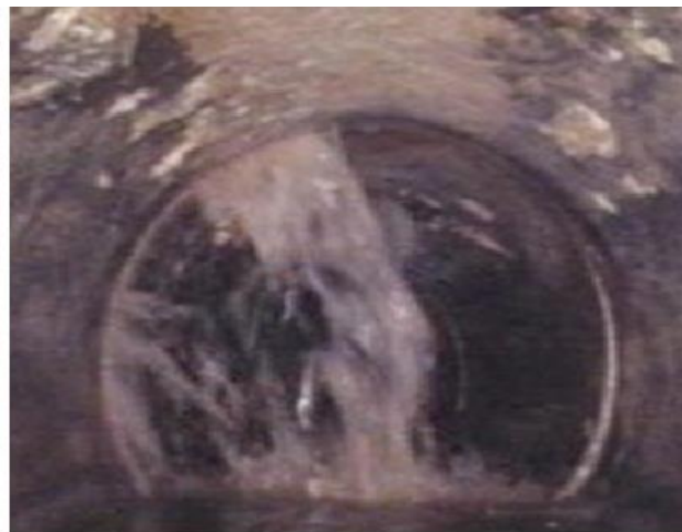
Infiltraciones de agua a través de colectores y pozos, por falta de estanquidad en juntas y hormigón
