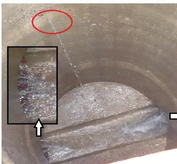
Infiltraciones de agua a través de colectores y pozos, por falta de estanquidad en juntas y hormigón
