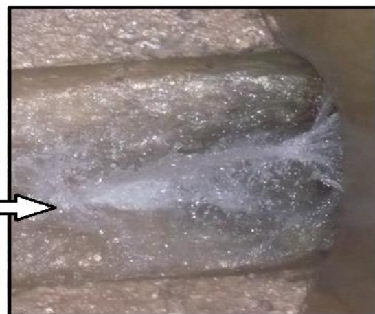
Infiltraciones de agua a través de colectores y pozos, por falta de estanquidad en juntas y hormigón
