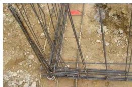
Noeud de chaînage - Continuité mécanique
