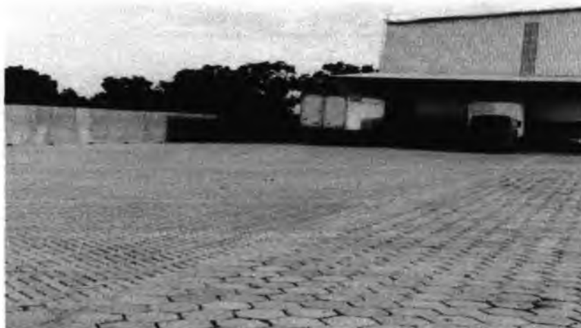
Imagem 06: Área do pátio externo de pavimentação de concreto em bloco sextavado de 25x25cm, espessura 8cm, sobre coxim de areia.
