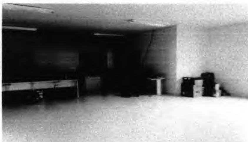
Imagem 05: Escritório parte interna da construção.
