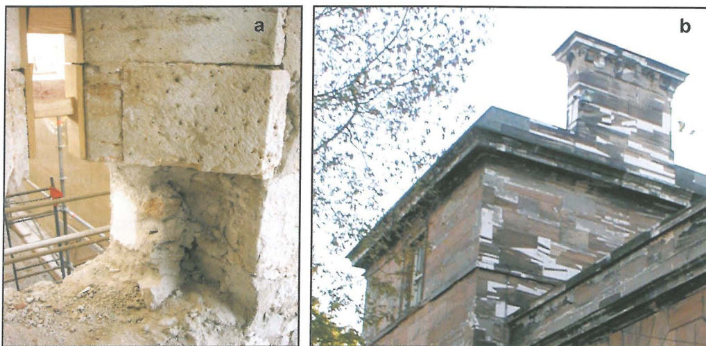
FIGURA 6. Sustitución de una pieza de la jamba de una ventana y restitución de sillares de la fachada con Piedra Natural.
