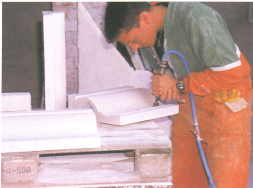
FIGURA 8. Tallado de piezas de cantería.
