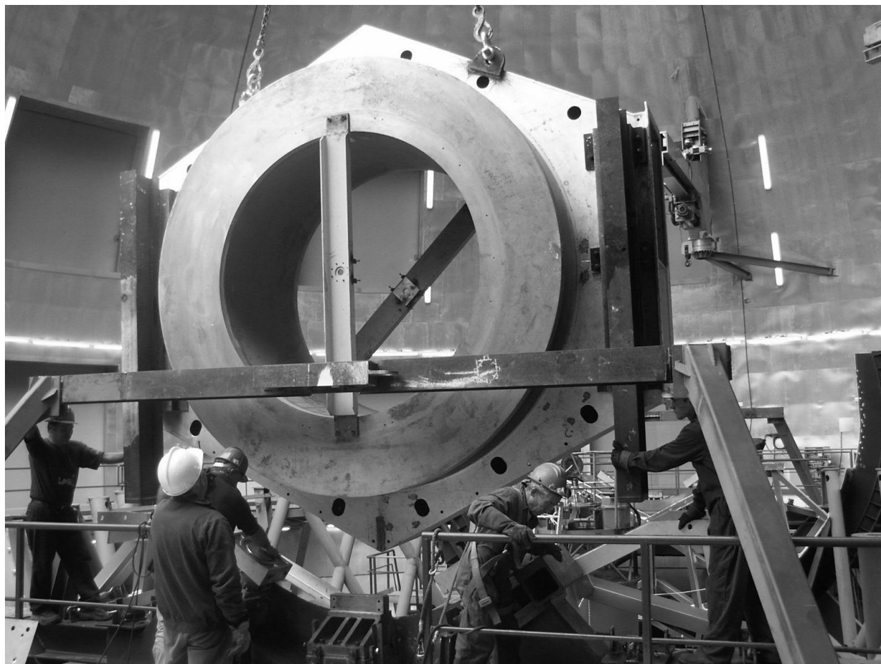
Figura 1 — Uno de los muñones de elevación siendo instalado en la estructura del telescopio.
