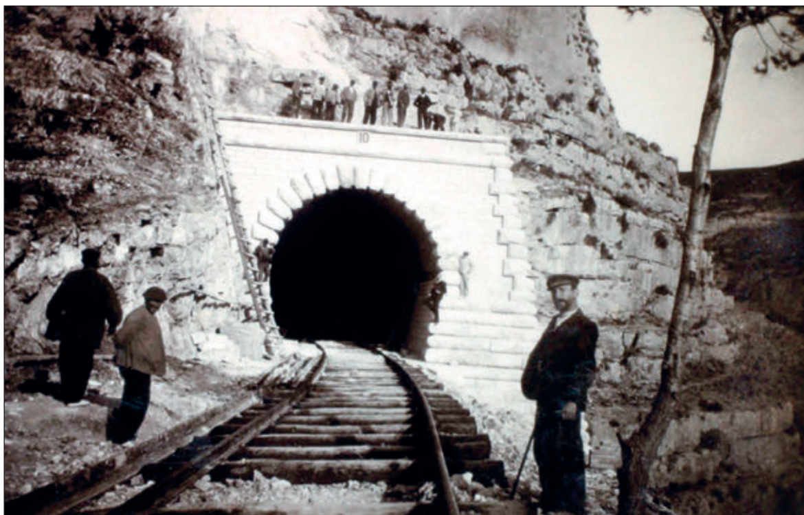
Túnel dels Viverets a Ontinyent
