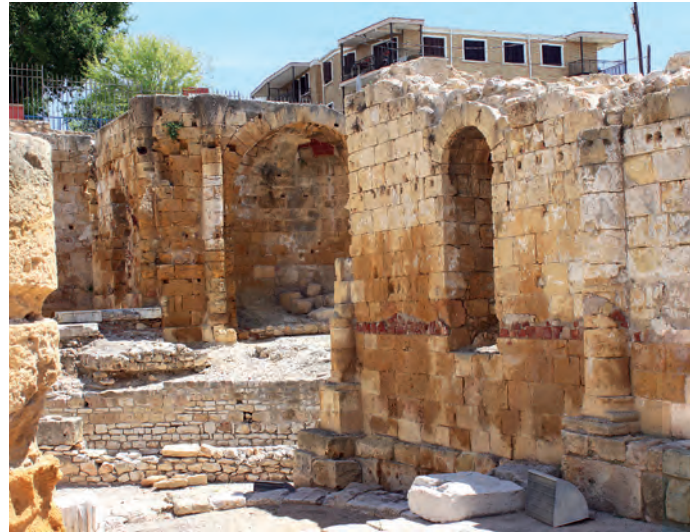
Segunda etapa. Tramo de la nave con ventana románica en primer término. Crucero y cabecera al fondo (Foto E. Liaño)
