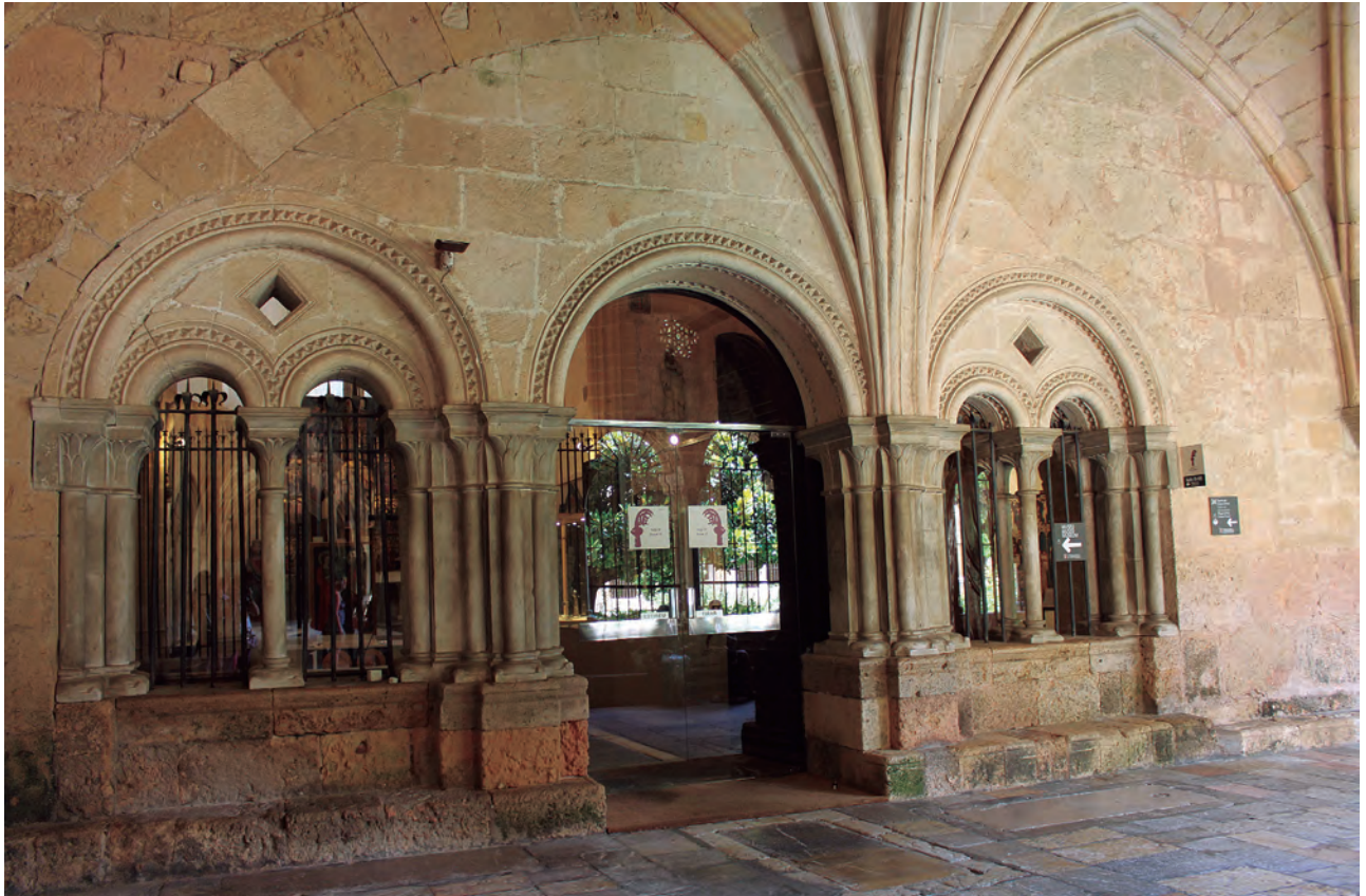
Claustro. Fachada de la sala capitular con su arco de descarga
