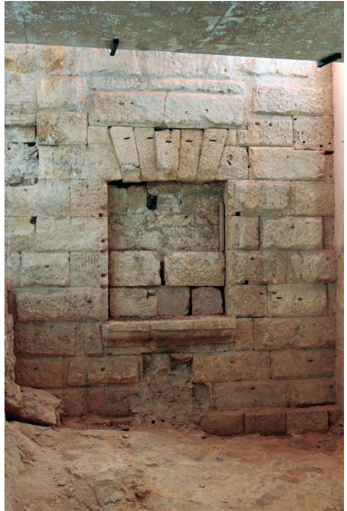
Zona nordoriental. Ventana del temenos romano clausurada desde la galería del claustro en la parte del primitivo refectorio
