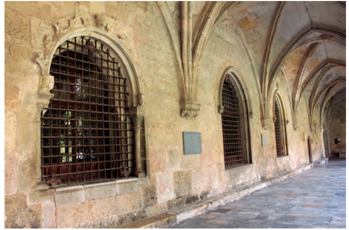
Claustro. Galería sudoriental con las ventanas de los siglos XVI al XIX de la sacristía
