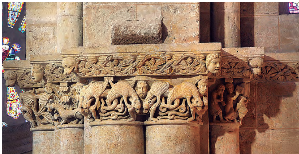
Capiteles de un pilar de la zona del presbiterio (Foto: URCOTEX I. S.L.)
