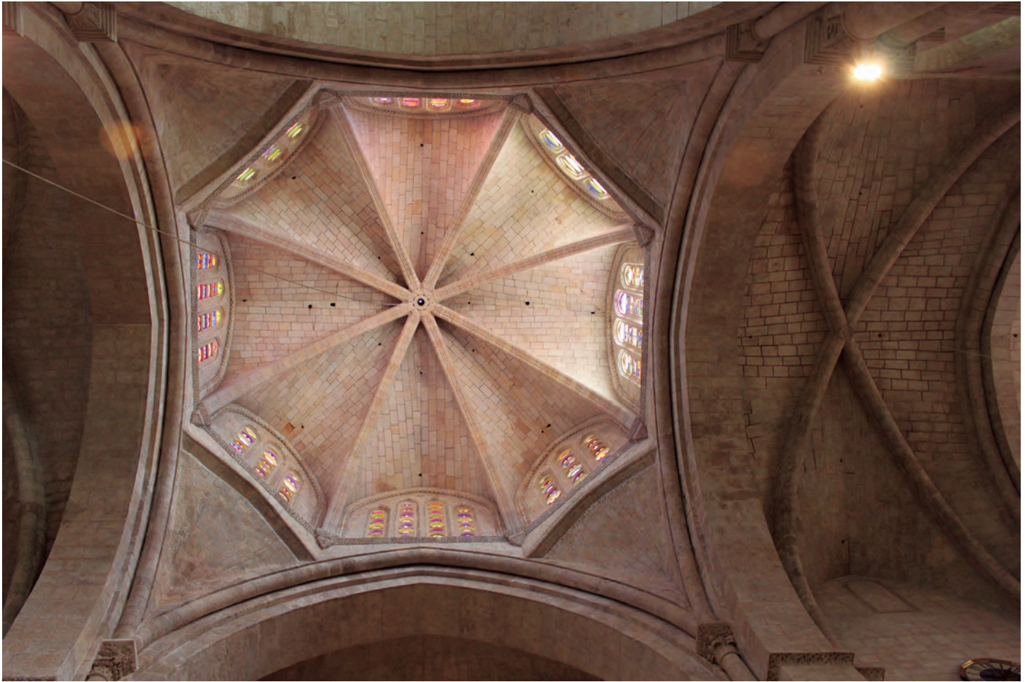
Cimborrio sobre el crucero
