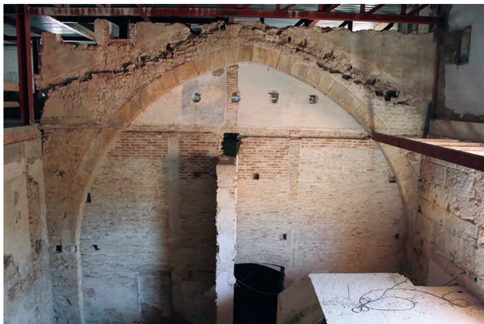
Zona nordoriental. Arco diafragma del dormitorio sobre los pilares del primitivo refectorio, en el interior del pórtico del temenos
