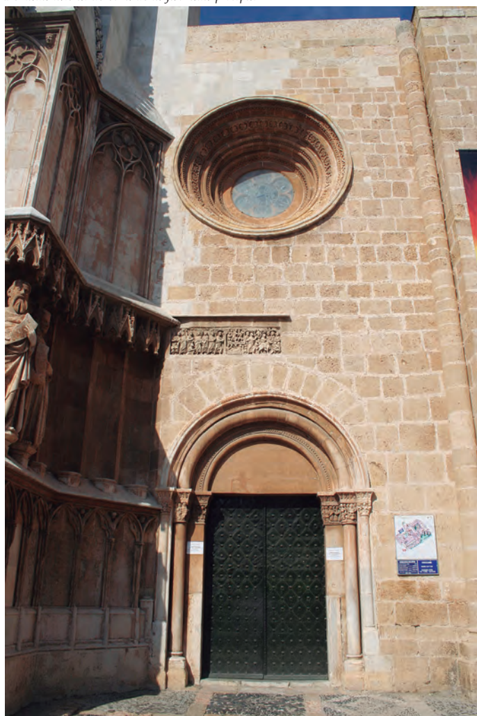
Portada lateral derecha de la fachada principal
