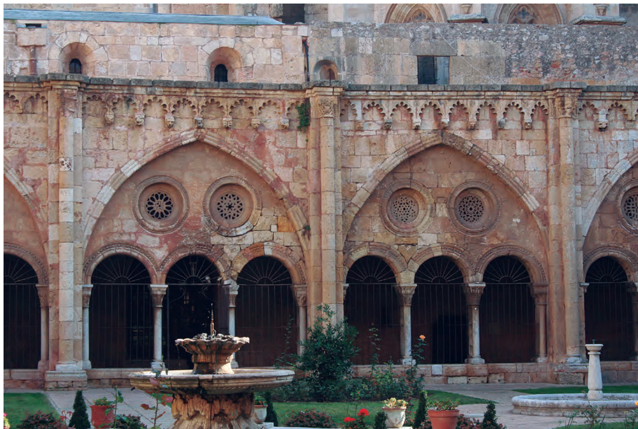
Vista de dos tramos del ala meridional desde el patio
