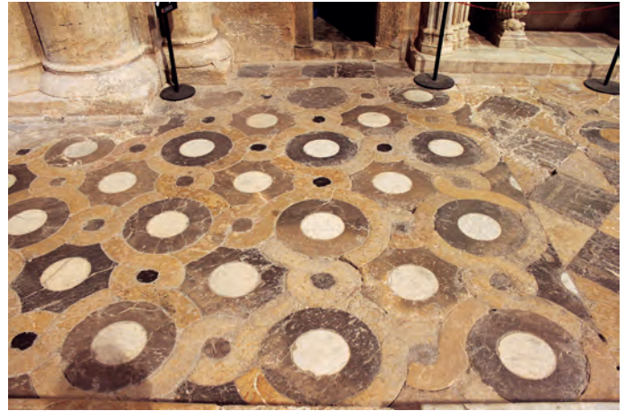
Detalle del pavimento del ábside mayor
