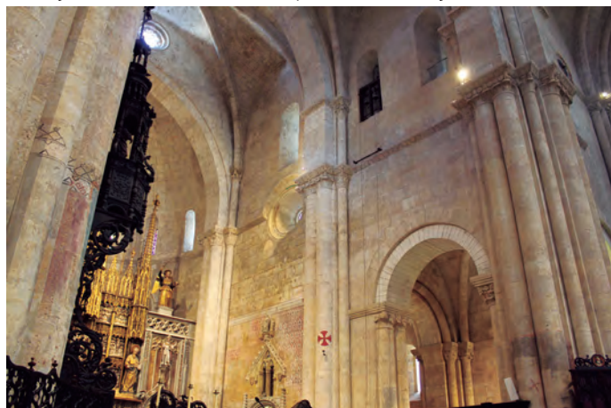
Muros y vanos románicos en los tramos previos al ábside mayor
