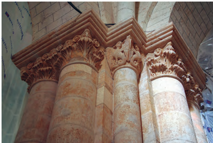
Grupo de capiteles del tramo previo a la capilla del lado de la Epístola, contigua al presbiterio
