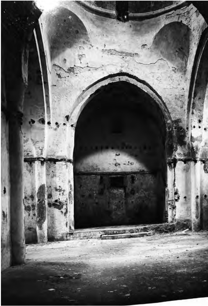
La iglesia románica. Segunda etapa. Ábside y crucero en 1909, antes de su demolición (Foto Archivo Mas, nº de Catálogo 3948)
