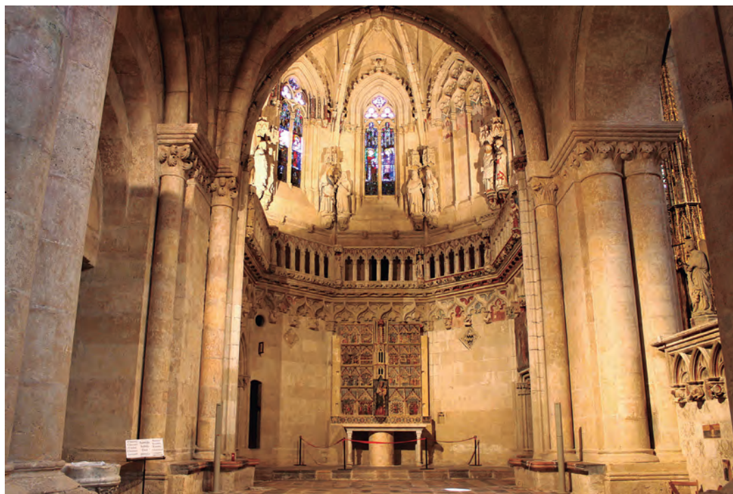
Capilla gótica de Santa María de los Sastres en la base de la torre románica frustrada
