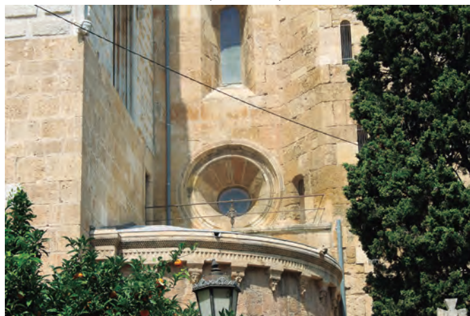
Ventana circular y tejeroz para la puerta del cementerio. El ábside lateral de San Lucas interceptó el hueco previsto
