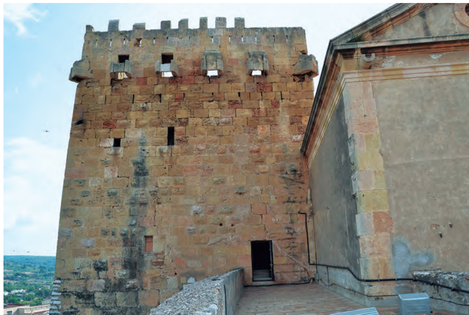
Detalle de la torre
