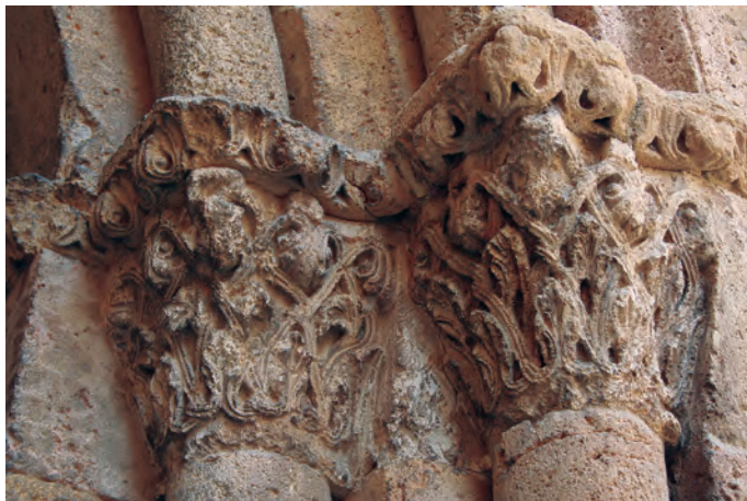
Capiteles de la Puerta llamada de Santa Tecla, en el lado de la Epístola, de la cabecera
