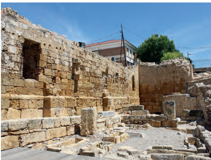
Primera etapa. Exterior del lado del evangelio. Materiales, zócalo y abertura moderna en primer término (Foto E. Liaño)
