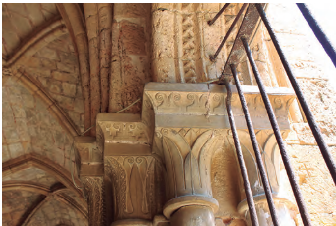
Claustro. Roques de Rocabertí y castillos de Castellet en la galería noroccidental
