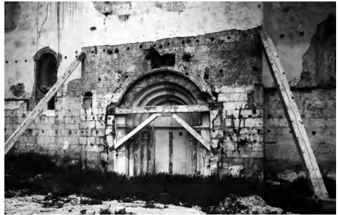
La iglesia románica. Segunda etapa. Portada principal antes de su demolición (Foto Archivo Mas, nº de Catálogo 3947)
