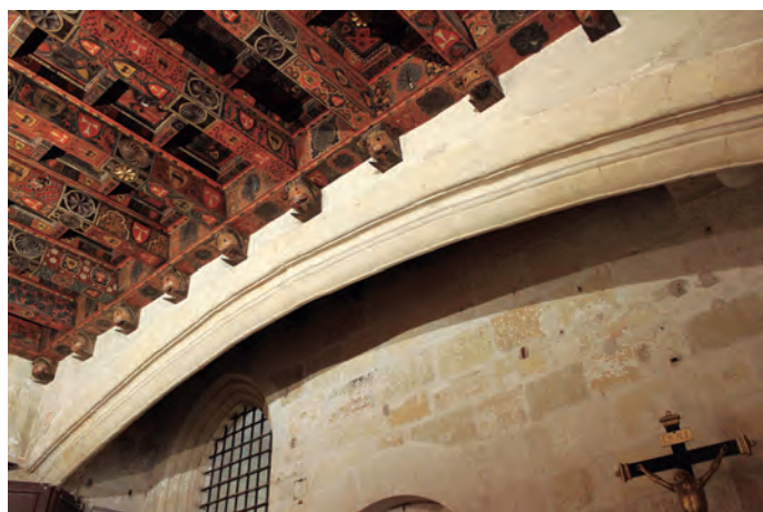
Sacristía. Arco transversal y estructura de madera policromada del coro del siglo XIV. A la derecha, muro divisorio del siglo XVI
