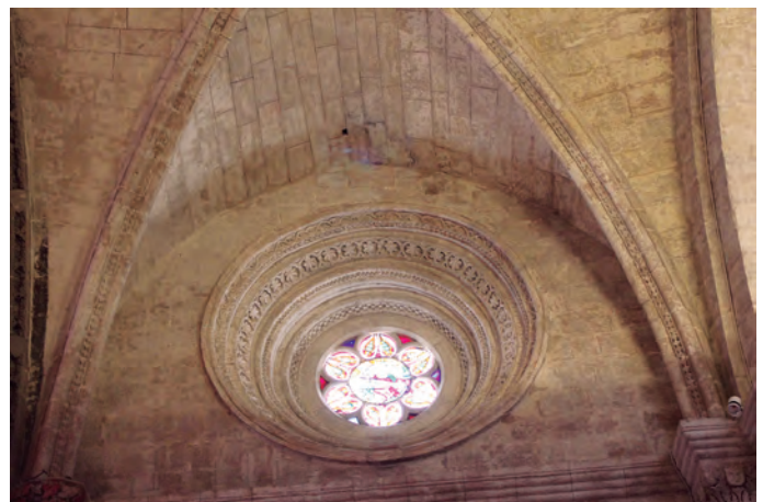
Fachada principal. Óculo de la puerta lateral de la epístola por el interior
