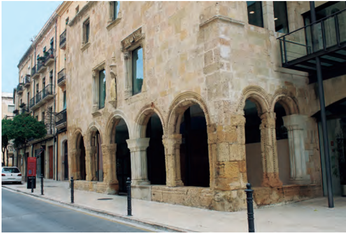
Fachada con el porche
