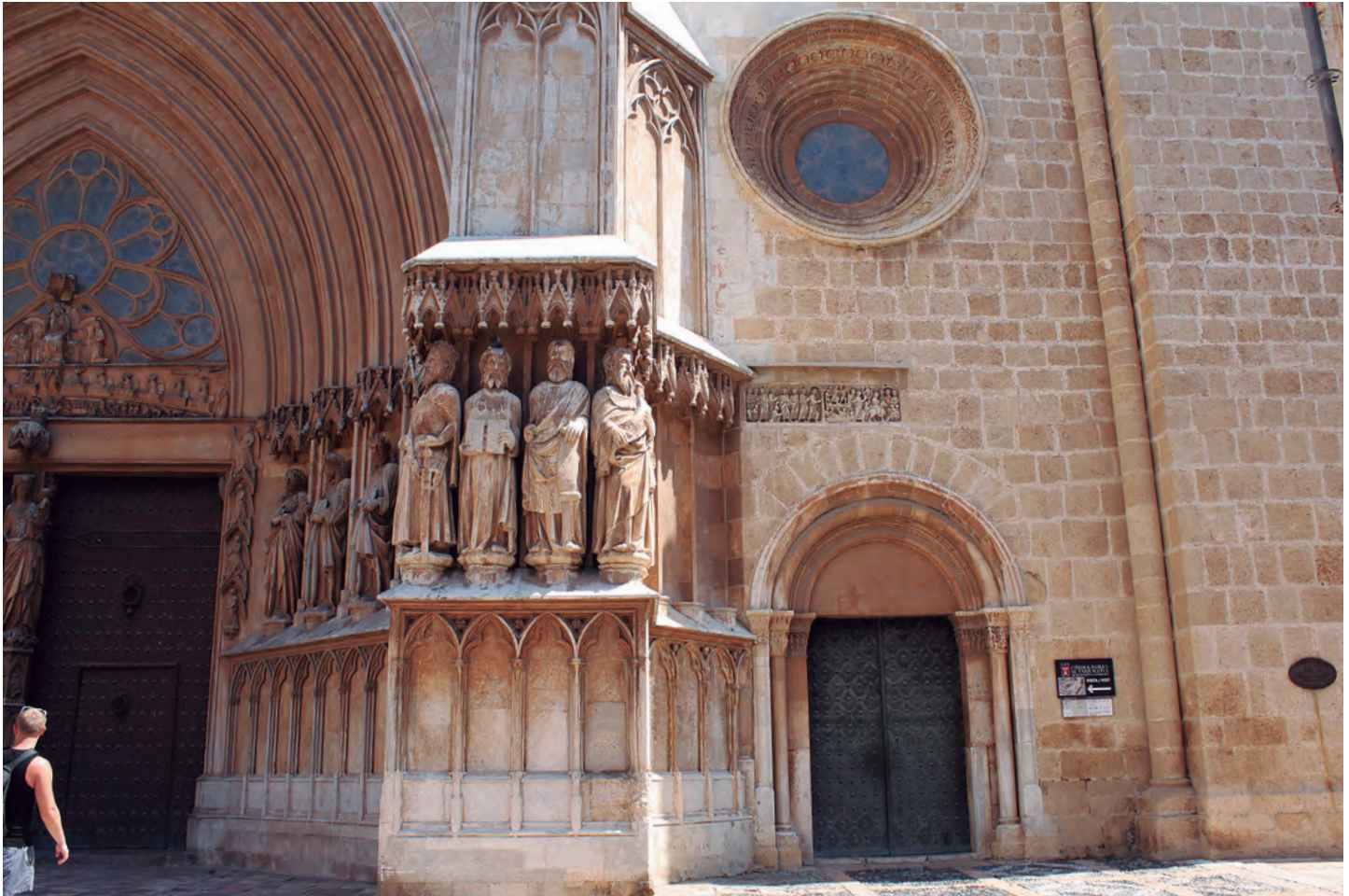
Fachada principal. Puerta lateral de la epístola y ventana circular relacionadas con el encargo del arzobispo Bernat de Olivella
