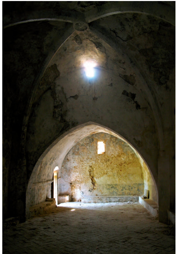
Interior del tramo antiguo de nave
