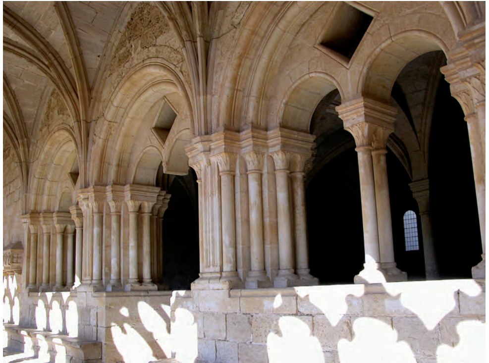
Sala capitular. Fachada hacia el claustro
