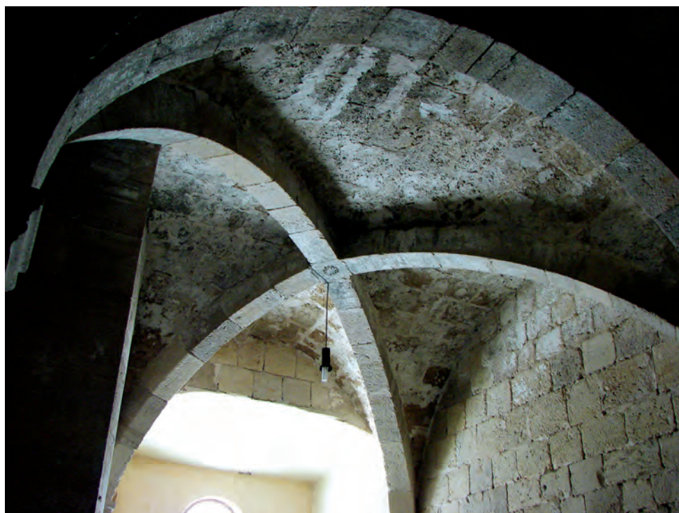
Bóveda de la sacristía
