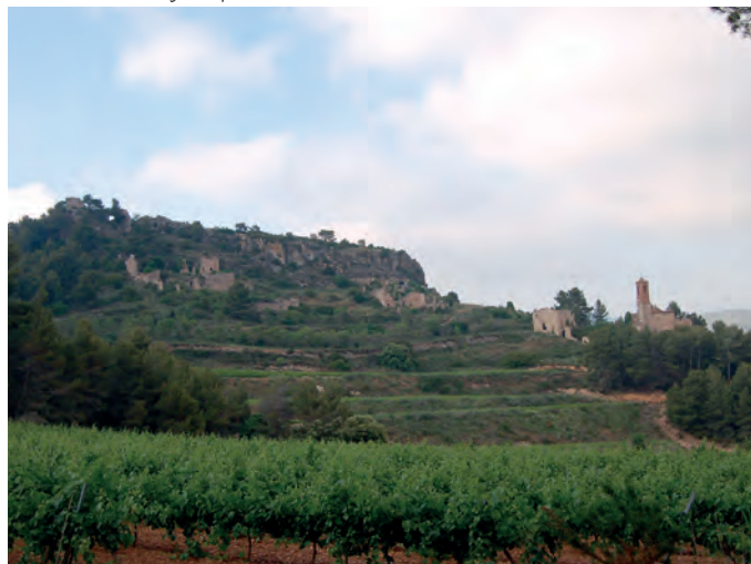
Restos del castillo y del pueblo abandonado
