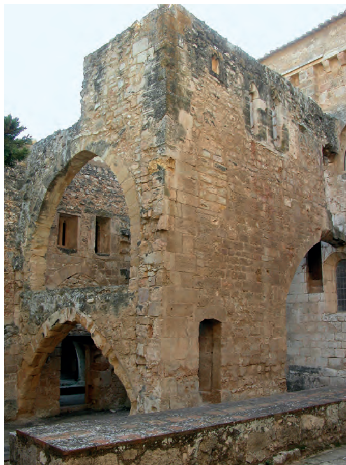
Edificio adosado al dormitorio de monjes
