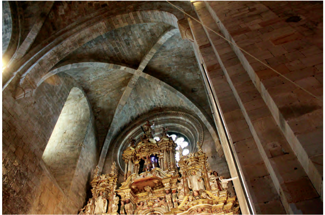
Bóveda del ábside central
