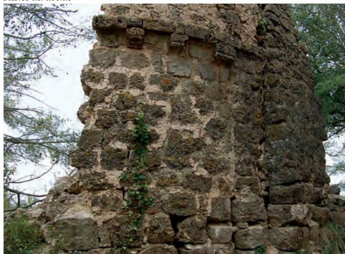
Restos del ábside
