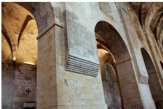
Arcos y ménsulas de las naves
