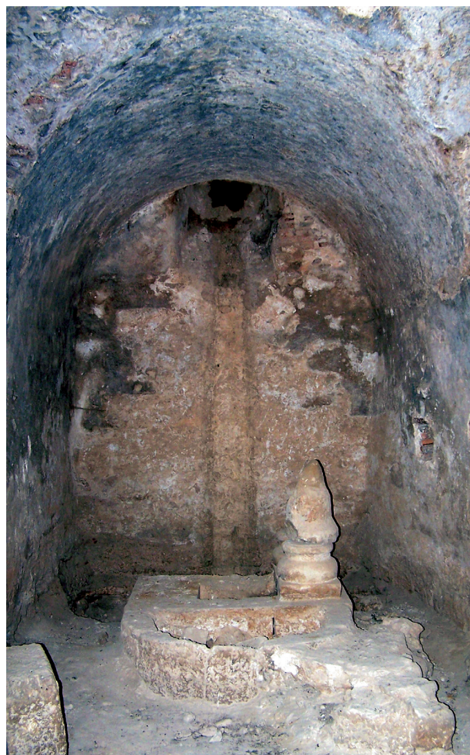
Interior de la cripta
