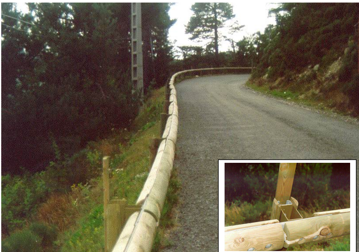
Foto 41: Quitamiedos- Clase de riesgo 3.1. Obsérvese el detalle del apoyo
