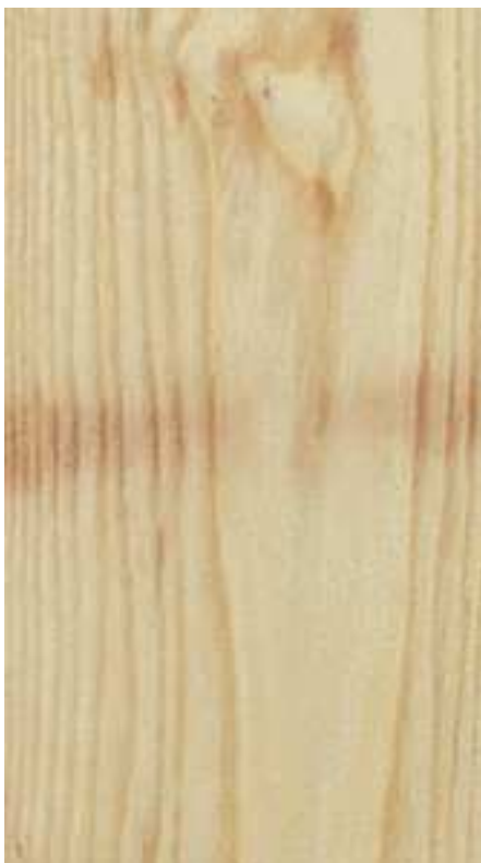
Foto 29: Marcas de rastreles
