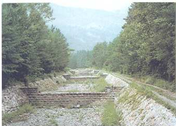
Senie di opere trasversali di tipo tradizionale a gravità, con gaveta a sezione rettangolare e rivestimento delle sponde in muratura di pietrame (Rio Domesteano - Comune di Tolmezzo).
