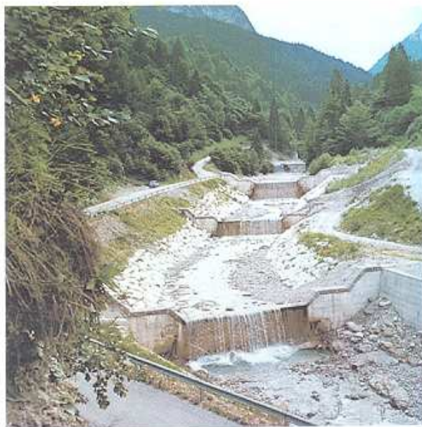
Sistemazione a gradinata , realizzata mediante l'impostazione di opere trasversali in calcestruzzo con gaveta rivestita in pietrame, e difesa delle sponde con scogliera in grossi massi a sdraio (T. Aupa - Comune di Moggio Udinese).
