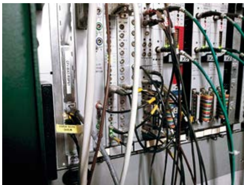
Figura 1. Alrededor de 900 cajas basadas en VME se utilizan en el CERN para controlar los aceleradores de los diversos experimentos.
