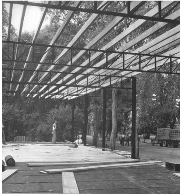
Imagen 150 Pabellón de la República de Brasil Construcción 1953. Clusellas. Fuente: AAVV (2012)
