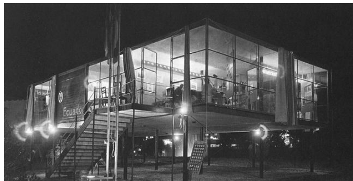
Imagen 147 Pabellón de la República de Ecuador 1953. Clusellas y Janello. Fuente: AAVV (2012)
