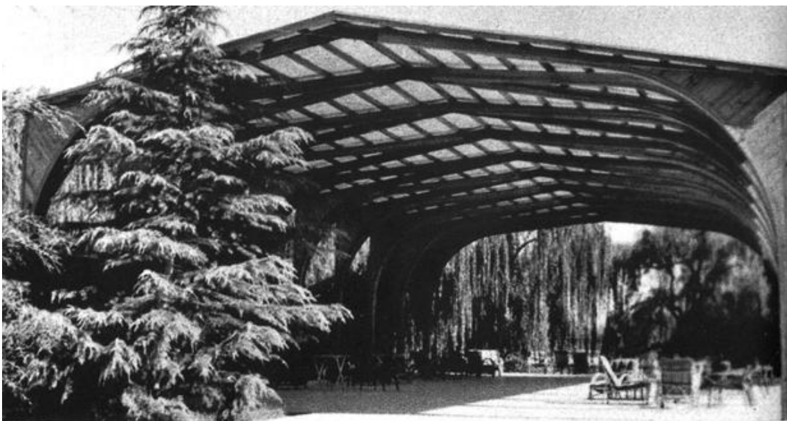
Imagen 160. Cubierta de la pista de baile 1953. Clusellas. Fuente: AAVV (2012)
