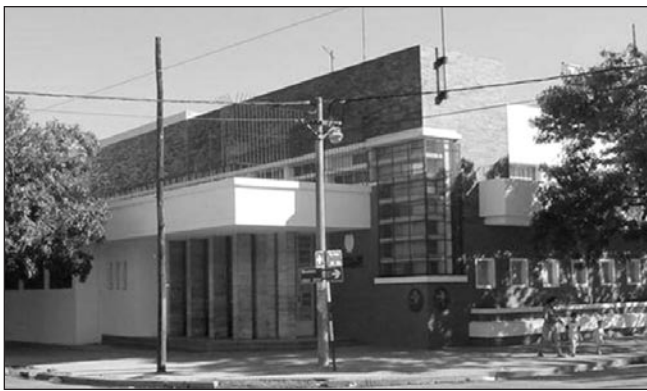
FIGURA 8 | ingreso al Parque del Sur (arriba); Escuela J. Arzeno (abajo).
