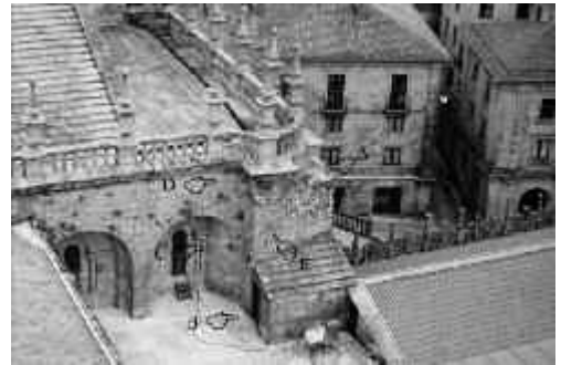
Fig. 12. Detalle del ángulo oeste de la fachada de las Platerías. A- Contrafuerte exterior sobre el que se apoya el Pasadizo del Tesoro, B- Caja de las antiguas escaleras al Tesoro, C- Restos de la torrecilla circular románica, D- Arranque de la Torre del Ángel, E- Contrafuerte de la Torre del Ángel.
