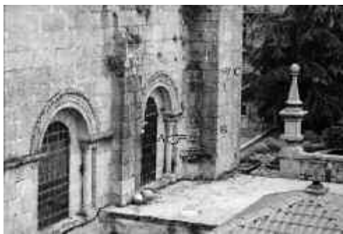
Fig. 14. Extremo norte del muro oriental del transepto septentrional de la catedral. A-Restos de la torrecilla circular románica, B-Contrafuerte, C-Muro de la actual fachada de la Azabachería.
