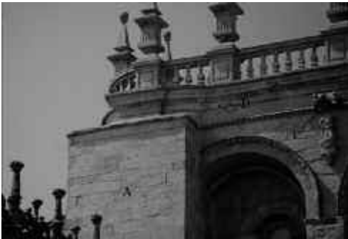
Fig. 11. Detalle de la zona alta de la fachada de las Platerías, ángulo oeste. A- Contrafuerte exterior sobre el que se apoya el Pasadizo del Tesoro, B- Restos de la torrecilla circular románica, C- Imposta de bolas, doseles y figuras de la Anunciación, D- Arranque de la Torre del Ángel.
