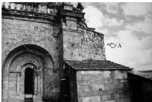
Fig. 13. Extremo meridional del muro occidental del transepto sur de la catedral. A- Contrafuerte exterior sobre el que se apoya el Pasadizo del Tesoro, B-Caja de las antiguas escaleras al Tesoro, C-Muro de la actual fachada de la Azabachería, D-Arranque de la Torre del Ángel, E-Contrafuerte de la Torre del Ángel, F-Relieve gótico.
