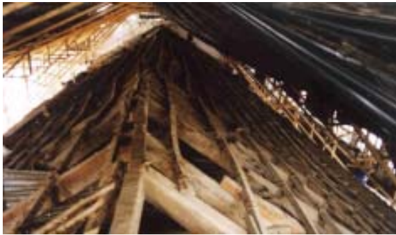
Estructura de cubierta original
