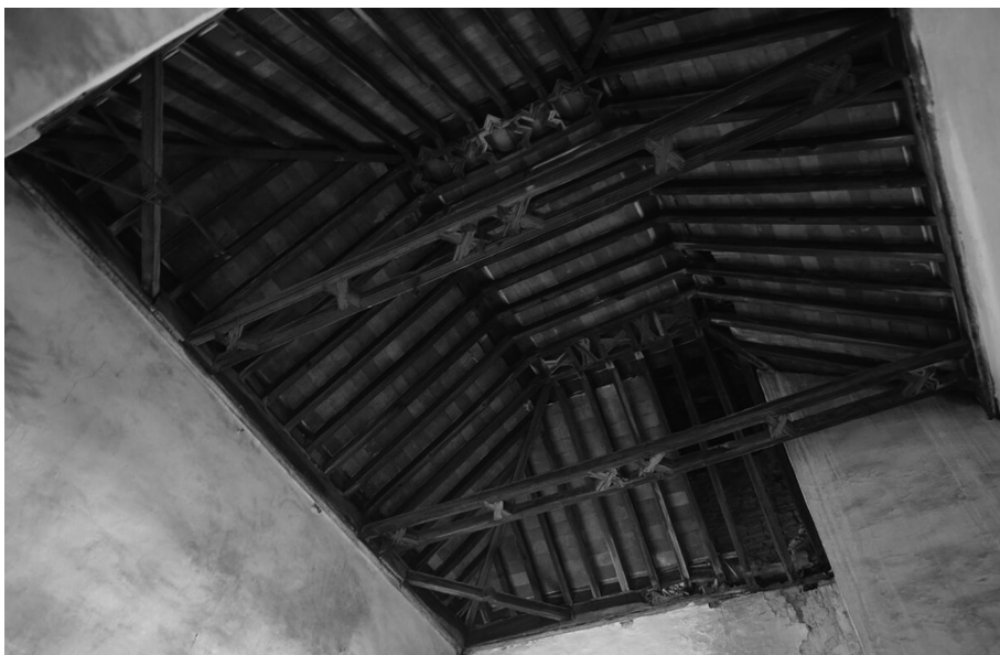
Fig. 9: Armadura de cubierta en el convento de Santa Inés de Sevilla.
