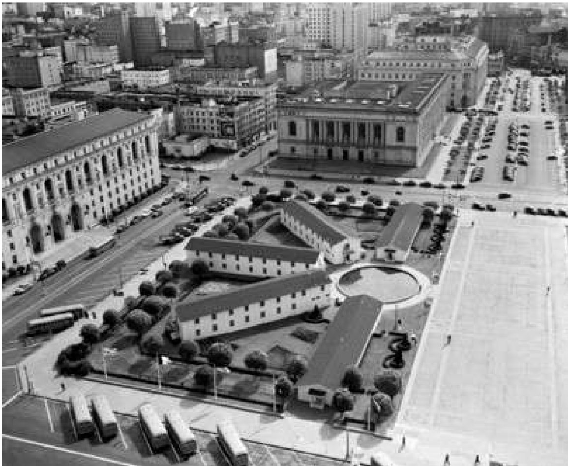
Barracas de uso temporal en el Civic Center, sede de la Conferencia Internacional de San Francisco. United Nations News & Media (Photo), 25 de abril de 1945, San Francisco, Estados Unidos.
