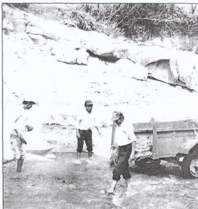
Las familias beneficiarias de los proyectos contribuyen acopiando piedra y arena en la construcción de las obras de riego.
