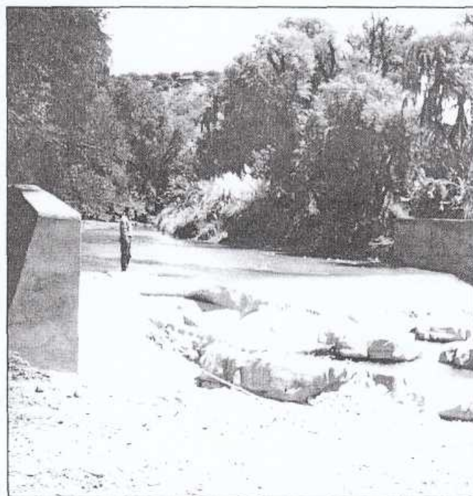
Obra de toma en Tárcana, Chuquisaca.
