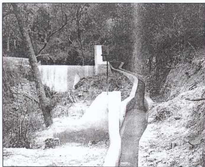
Obra de toma en Hoyada Chica, Chuquisaca
