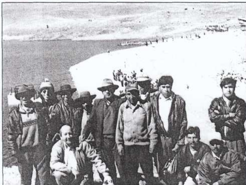
En la entrega de la obra, los comunarios "challan" la presa Chankas para que perdure.
