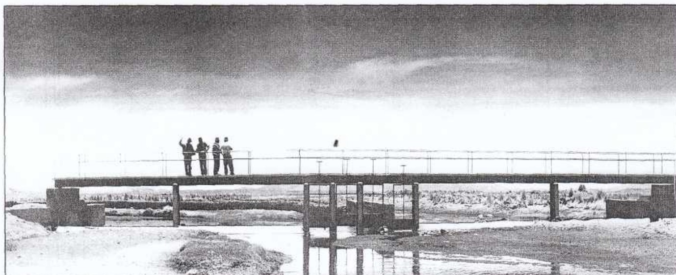
Obra de Toma en el río Pusuhuma. La Paz
