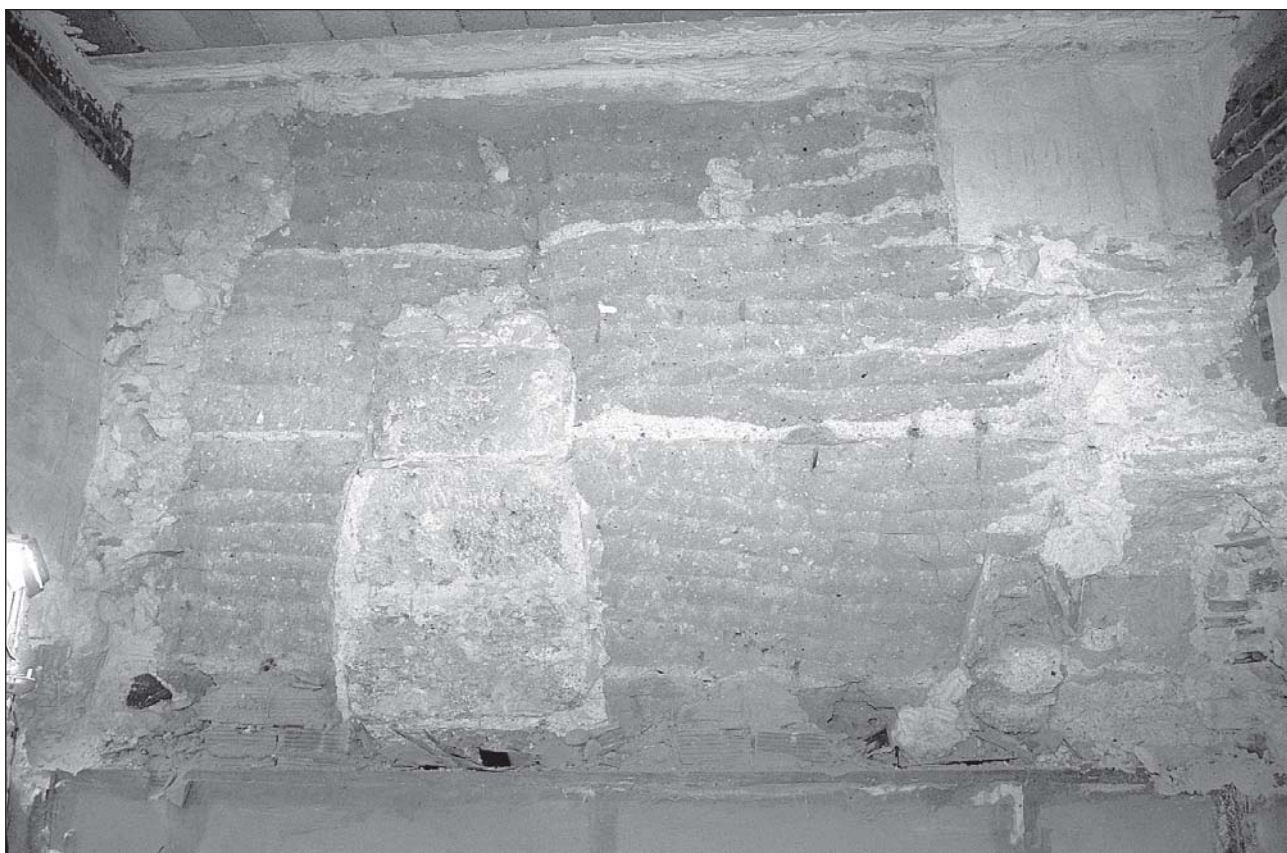
Foto 5: Detalle del muro N de la torre de la Vera Cruz.
