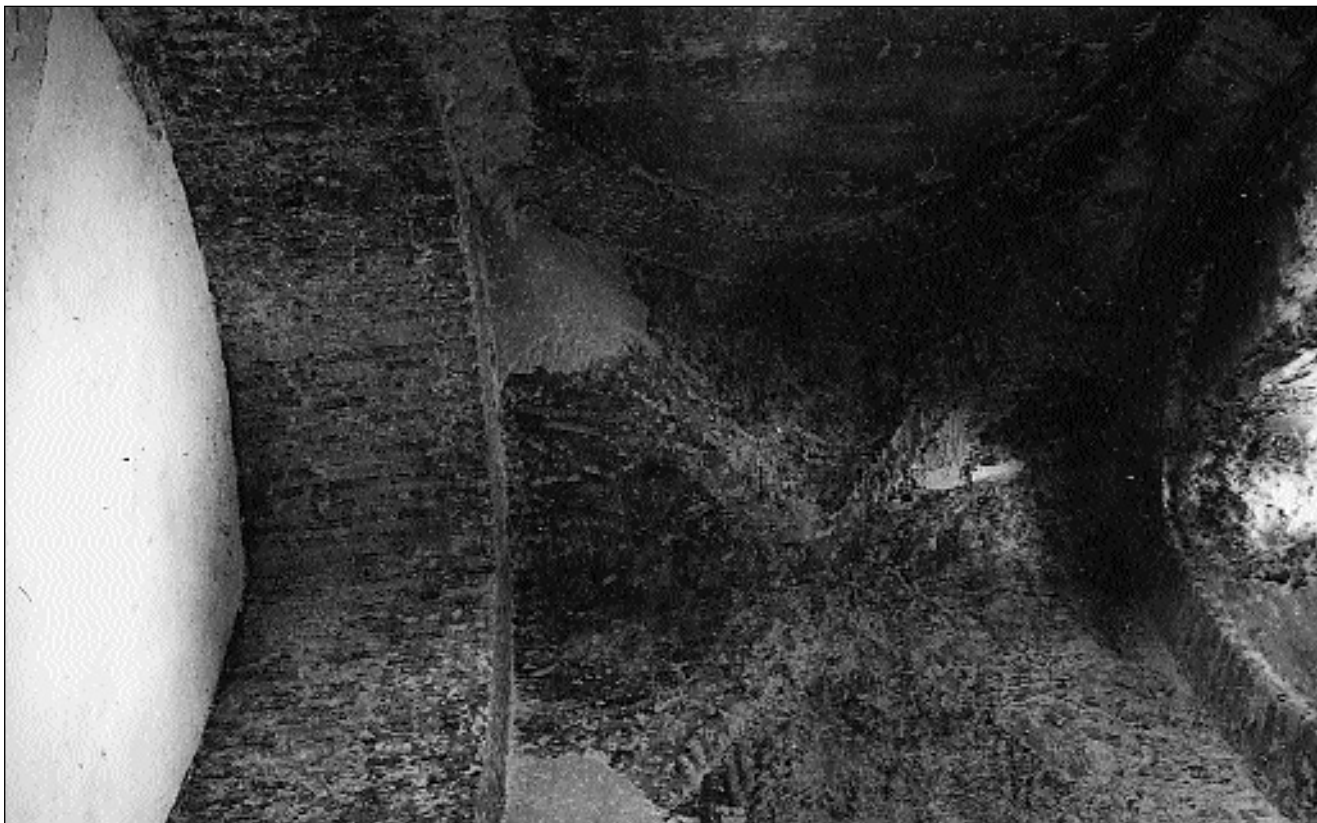
Figura 20.- Torre Vieja, detalle de los arcos y bóvedas de la planta baja
