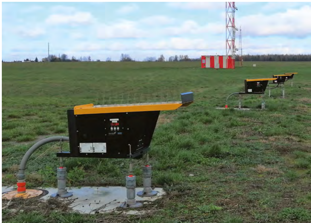
Fot. 6. Precyzyjny wskaźnik ścieżki podejścia PAPI. W tle anteny systemem ILS/DME Autor: B. Marciniak, Port Lotniczy Poznań-Ławica
