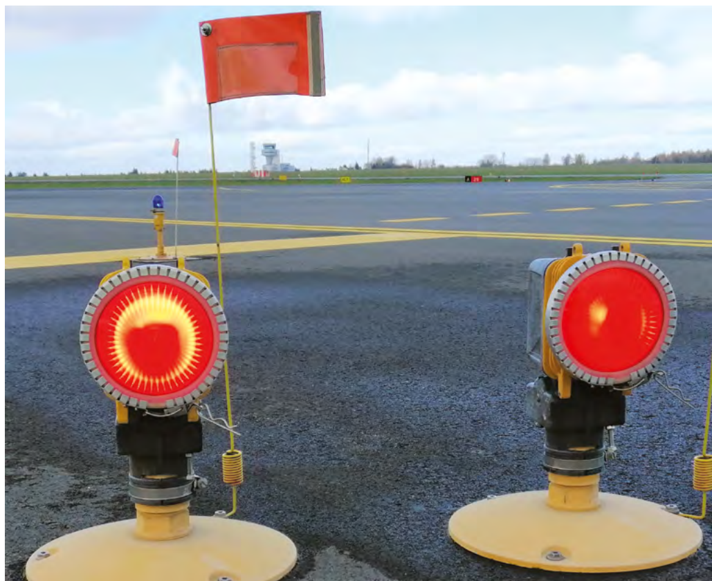
Fot. 1. Światła nawigacyjne zainstalowane na drodze startowej Autor: B. Marciniak, Port Lotniczy Poznań-Ławica
