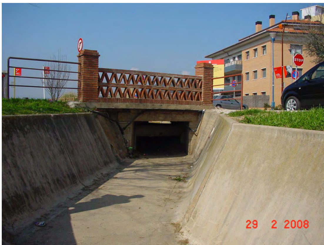
Vista Riera canalitzada aigües amunt des de secció 2
