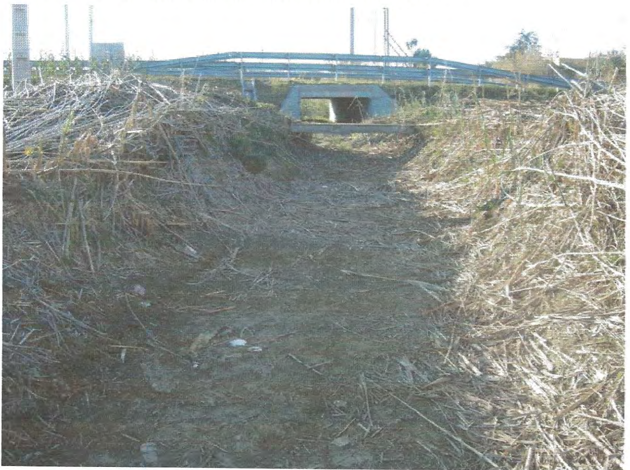
28.- Secció PK – 118 Riera d'en Burgada, aigües avall d'unió dels recs.
