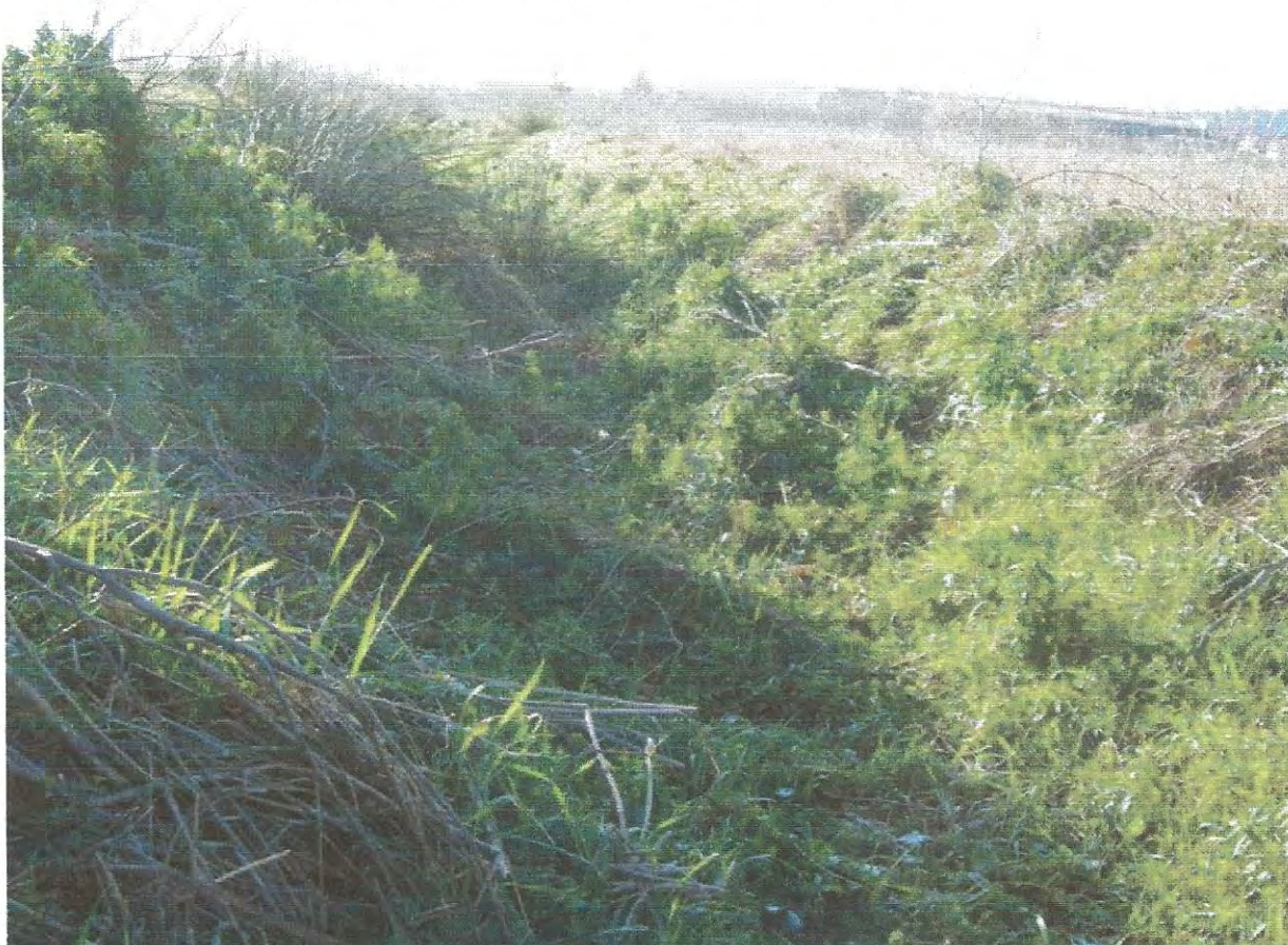
15.- Secció PK - 341 Rec del Molí. La llera - vista general a la esquerre sector 24.
