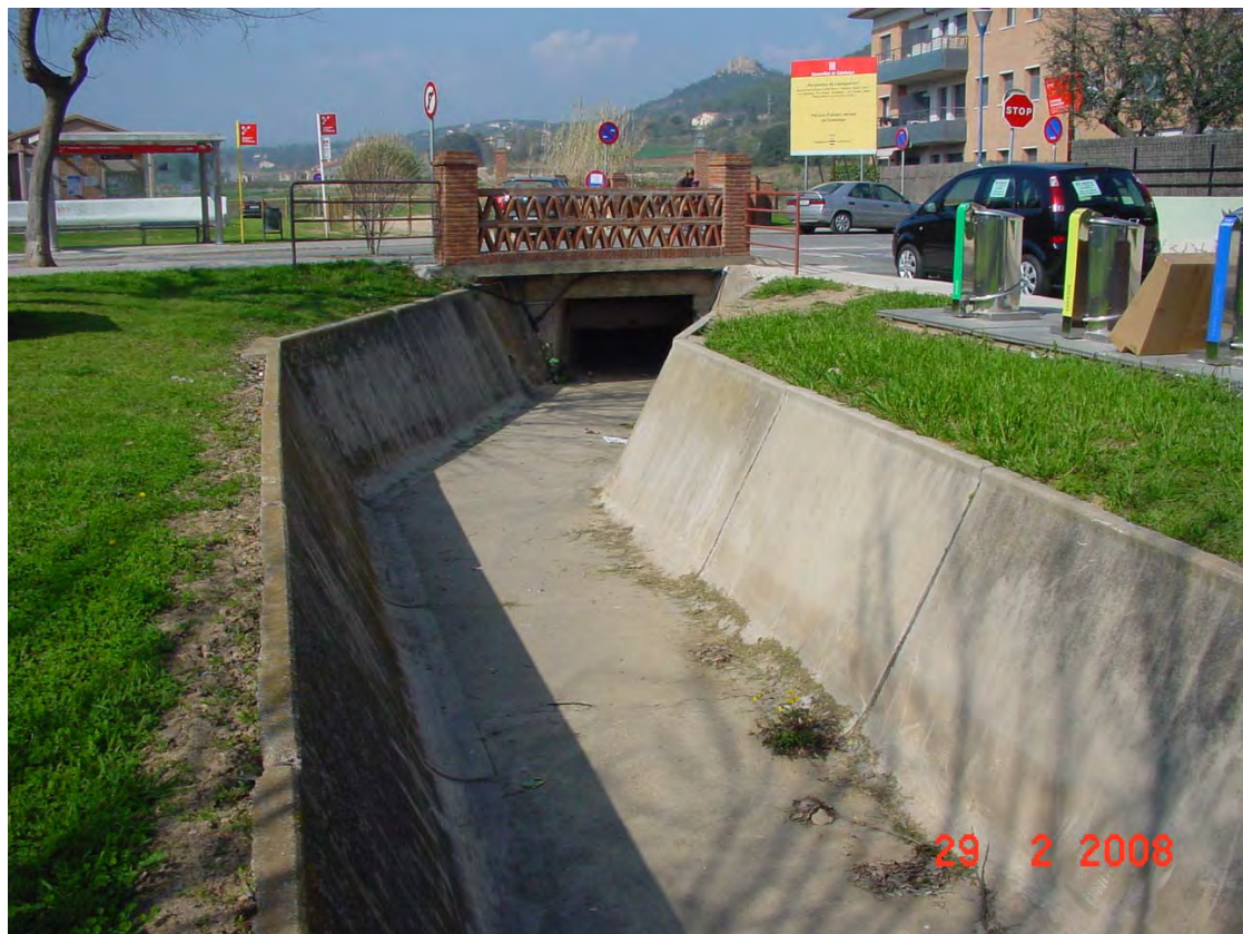
Vista Riera canalitzada aigües amunt des de secció 1
