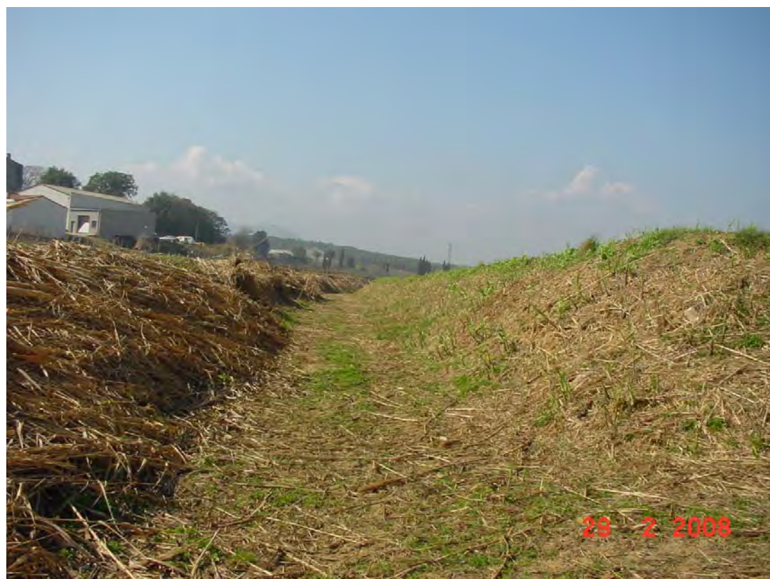
Vista estat actual Riera aigües amunt des de secció 18
