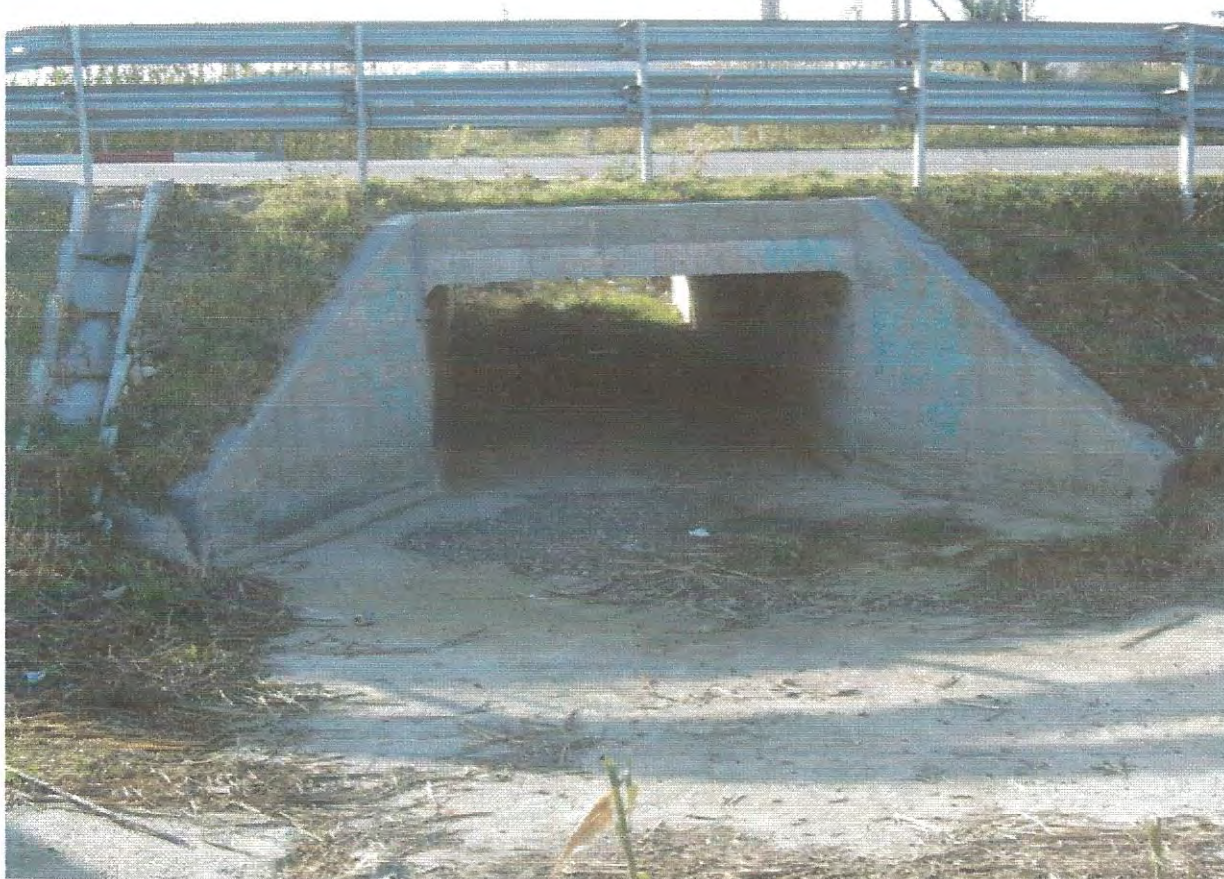
29.- Secció PK – 097 Obra de pas sota la nova carretera d'accés a Palafolls. Riera d'en Burgada, per la dreta ve un afluent Burgada - principal.
