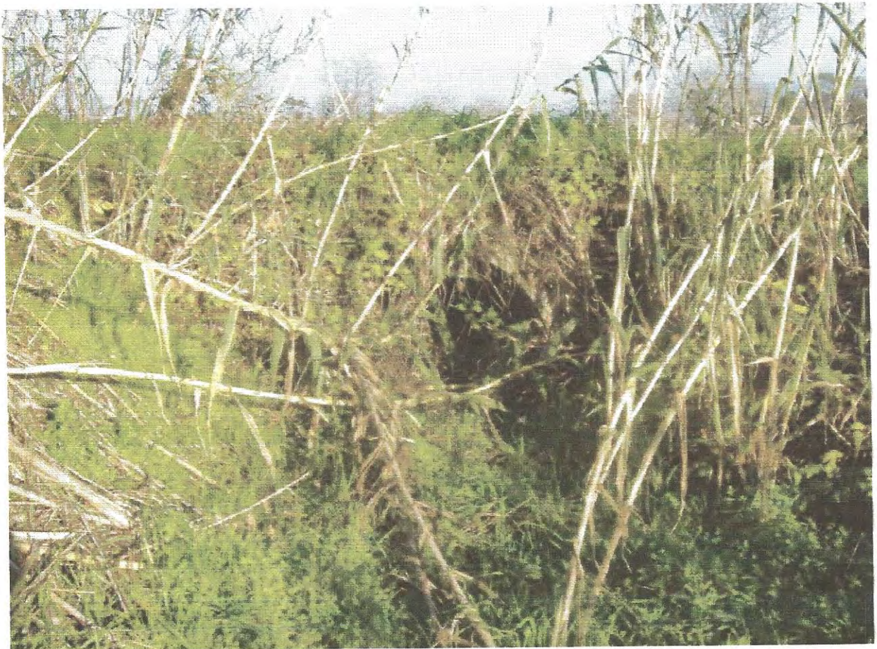
8.- Secció PK – 439 Rec del Molí. La llera, vista cap a aigües amunt, cap el tub de la obra de pas.
