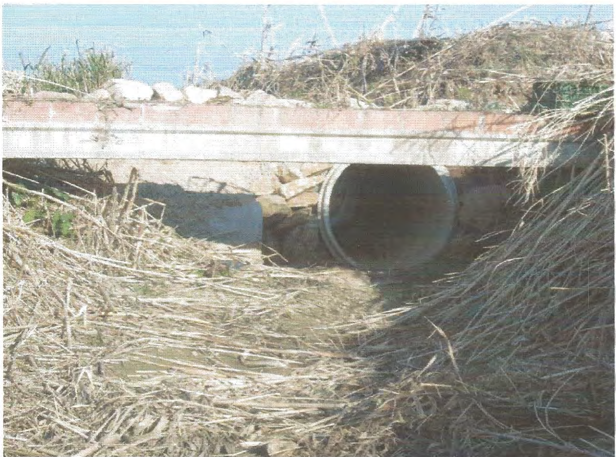
50.- Secció PK – 498 El Rec Viver. La llera, vista cap a aigües amunt. Obra de pas - canonada DN 1000 mm.
