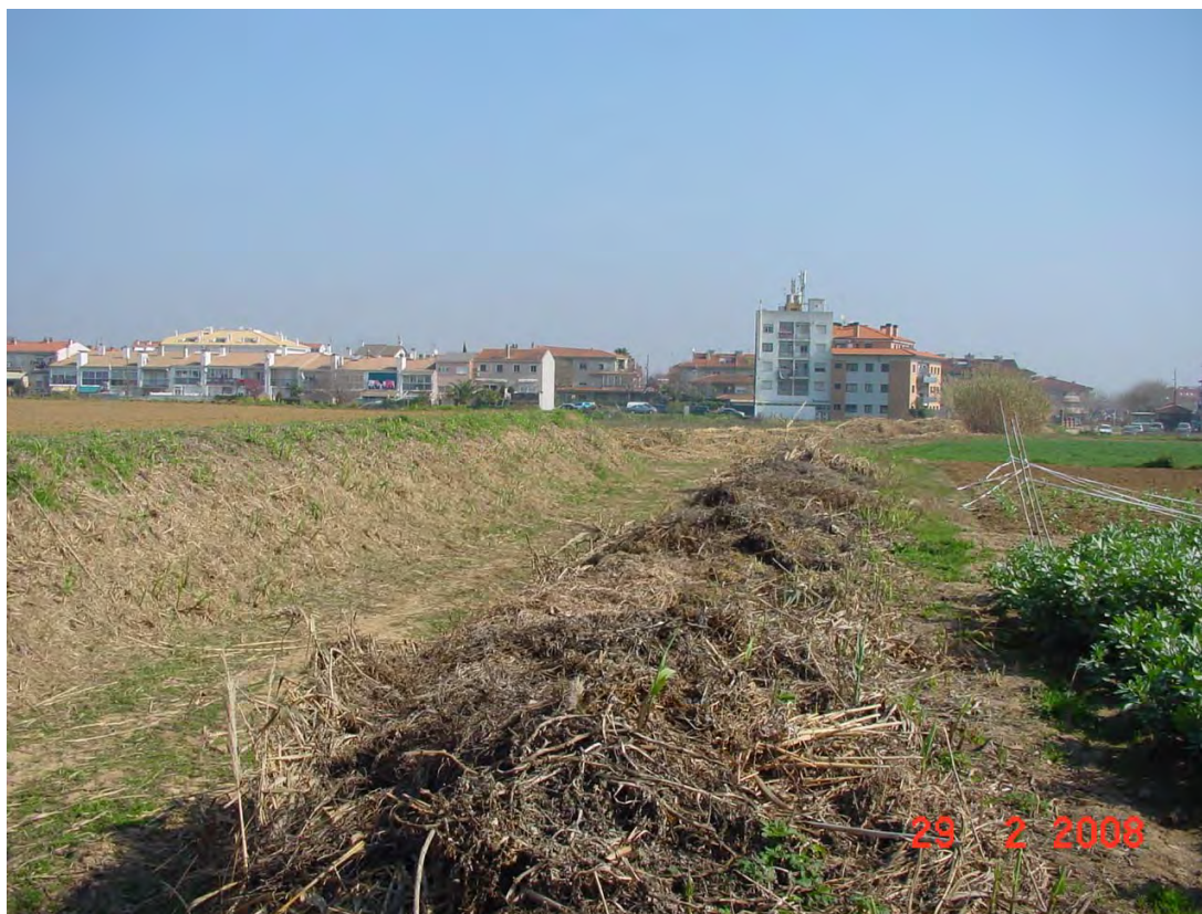
Vista aigües avall estat de la llera de la Riera des de secció 15
