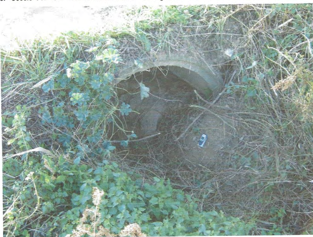
6.- Secció PK – 453 Rec del Molí. Obra de pas sota un camí tub de DN 1100 mm.
