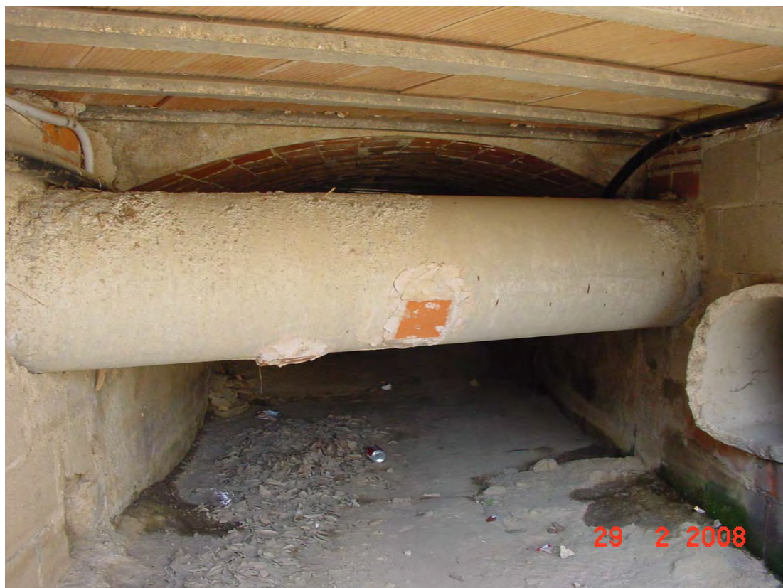
Detall interior sortida pont aigües avall
