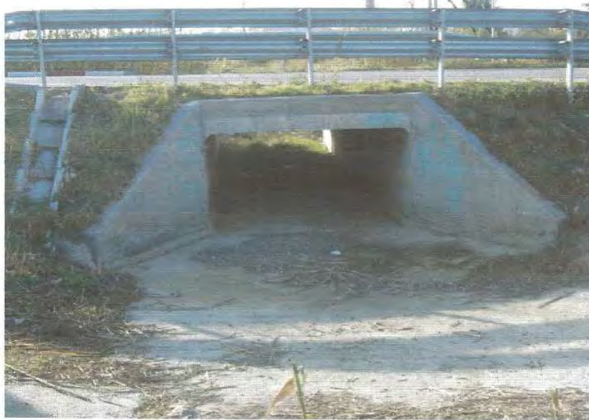
29.- Secció PK – 097 Obra de pas sota la nova carretera d'accés a Palafolls. Riera d'en Burgada, per la dreta ve un afluent Burgada - principal.
