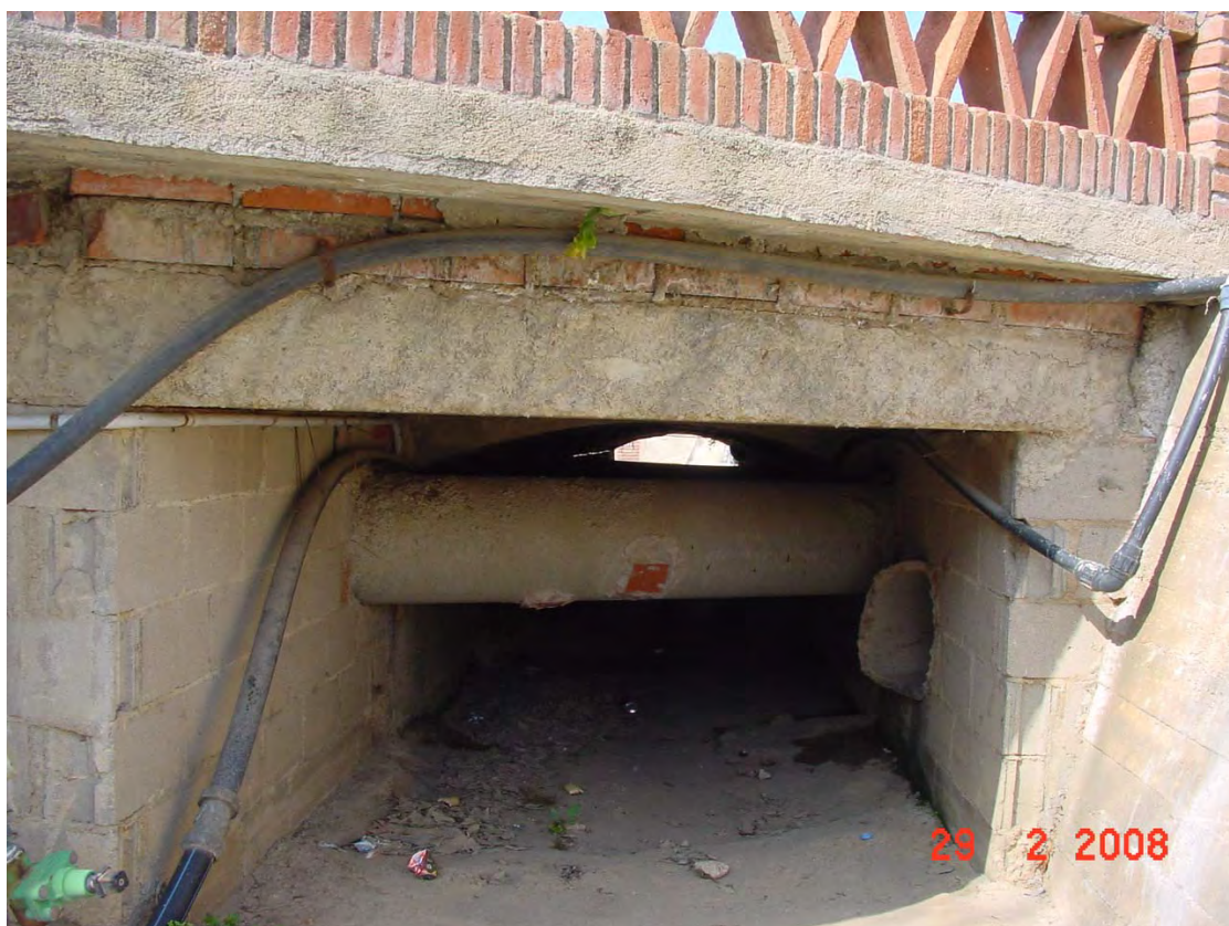
Detall interior sortida pont aigües avall
