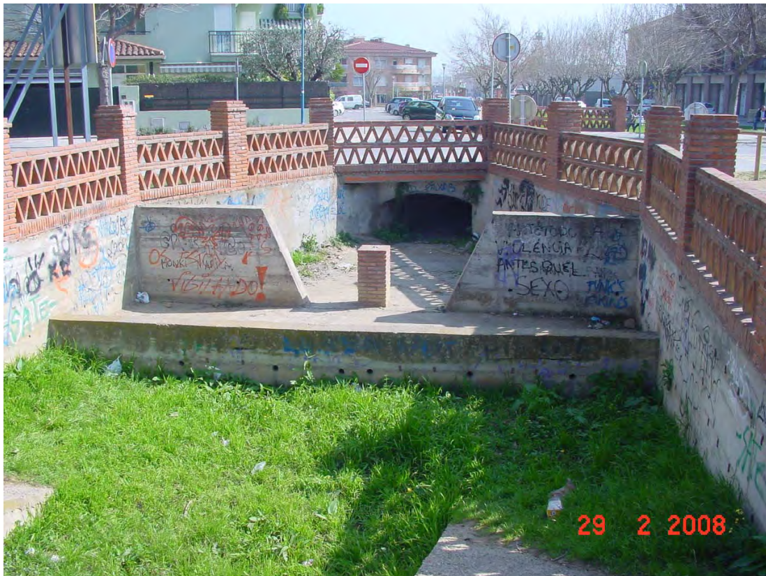
Vista aigües avall des de secció 5, entrada de la riera dins del poble i punt des del qual la riera passa d'un calaix natural a un canal de formigó
