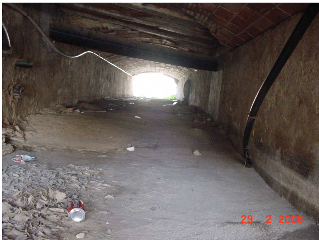
Detall interior sortida pont aigües avall
