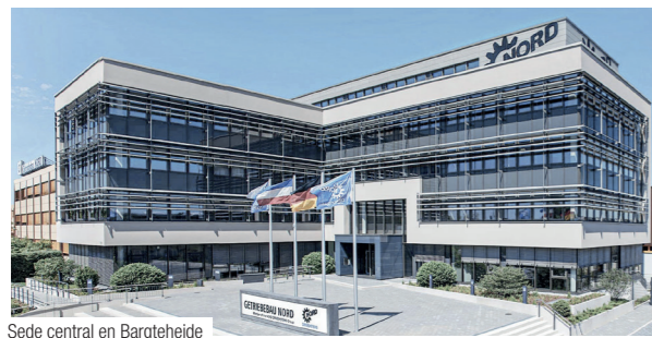
Sede central en Bargteheide
