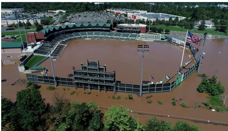
Fig. 18: Estadio de béisbol del TD Bank inundado por precipitaciones del huracán Ida.
