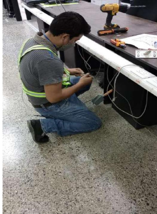
Instalación del cableado estructurado de voz y datos para las nuevas instalaciones de la Oficina de la Mujer
