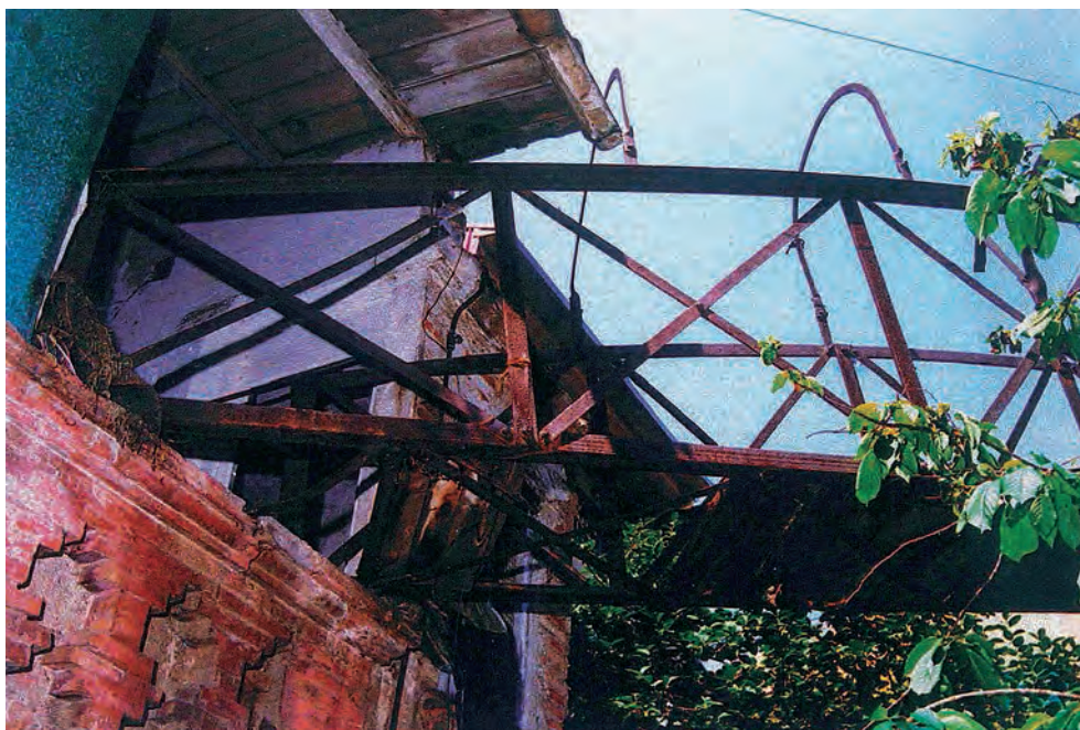
Figura 16. Un pont de ferro recuperat. Foto: J. Ventura
