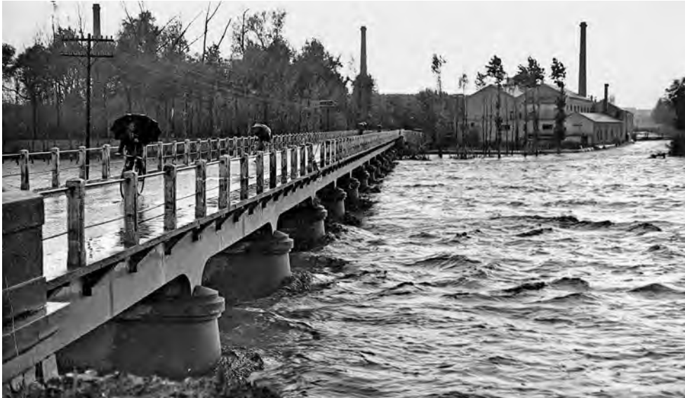
Figura 2. Pujada de les aigües del Besòs com a conseqüència de les pluges del 17 d'agost de 1950. Foto: J. Cuní
