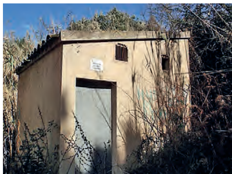
Figura 3. Caseta de cloració. Foto: A. Morera
