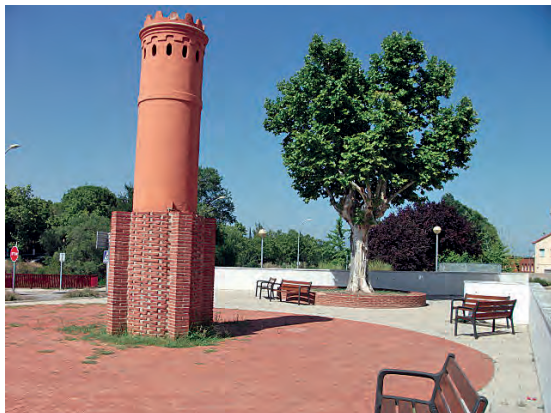
Figura 3. Dipòsit del Cementiri de 300 m 3 . Conegut amb aquest nom perquè està situat a prop del cementiri, en la confluència dels carrers Palaudàries, via de Ronda i plaça Frederic Ros, davant del pont del ferrocarril Barcelona a Puigcerdà. La torre de ventilació fou restaurada en els anys noranta. Foto: A. Collado
