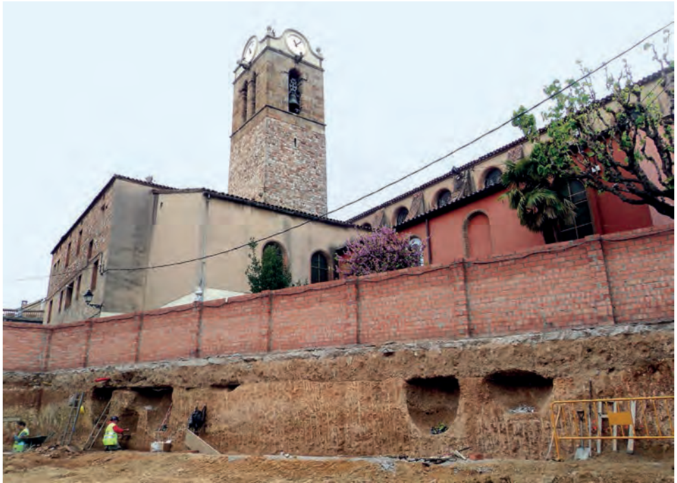
Figura 12. Vista de la meitat nord del solar del c/ Gaietà Ventalló, 15-23 en curs d'excavació amb les sitges medievals (s. XII-XIII) localitzades en el tall del marge, estenent-se cap a sota el c/ Sant Oleguer. Al fons, a escassos metres, es pot veure l'església de Sant Vicenç de Mollet amb el seu campanar romànic. Elaboració: J. Roig-Arrago, 2012
