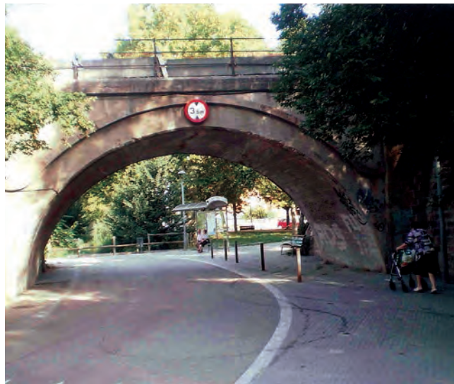
Figura 5. Pont de Lourdes. Foto: J. Ventura
