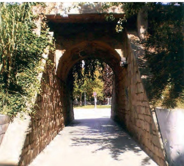
Figura 3. Pont de Santa Rosa per sota la via del tren de Barcelona-Puigcerdà, 1950. Foto: J. Ventura
