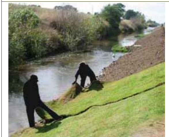
Figura 3. Instalación de tepes en la margen de un río
