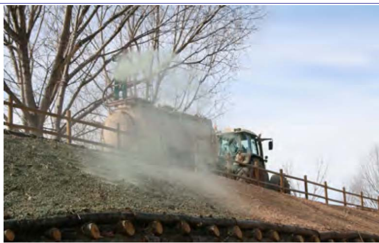
Figura 2. Hidrosiembra en los trabajos de mejora del espacio fluvial del Río Congost en La Garriga, Barcelona
