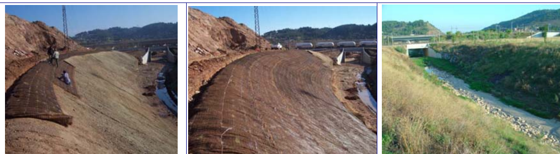
Figura 17. Instalación de geomalla permanente en los trabajos de restauración y estabilización de los márgenes del torrente de Llops en el término municipal de Martorell, Barcelona (izquierda y centro) y evolución tres años después (derecha)
