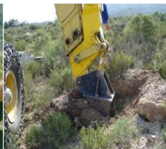
Ahoyado con retroexcavadora
