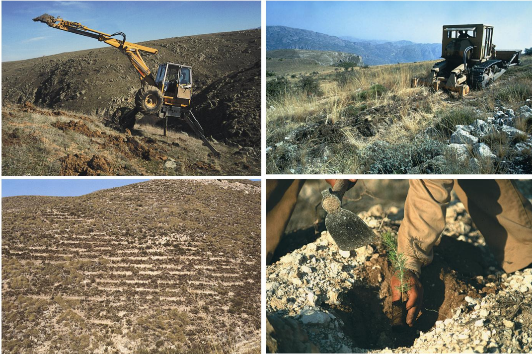
Ahoyado con retroexcavadora tipo "araña". Preparación lineal mediante subsolado con tractor de cadenas. Ladera preparada mediante fajas discontinuas al tresbolillo. Plantación manual de un pino con cepellón. (Fuente: V. Gómez, R. Serrada)
