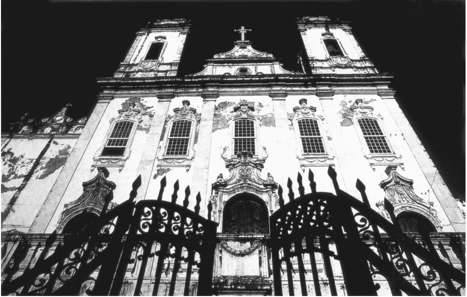
Fig. 46 Fachada de la iglesia del Carmen, Brasil
