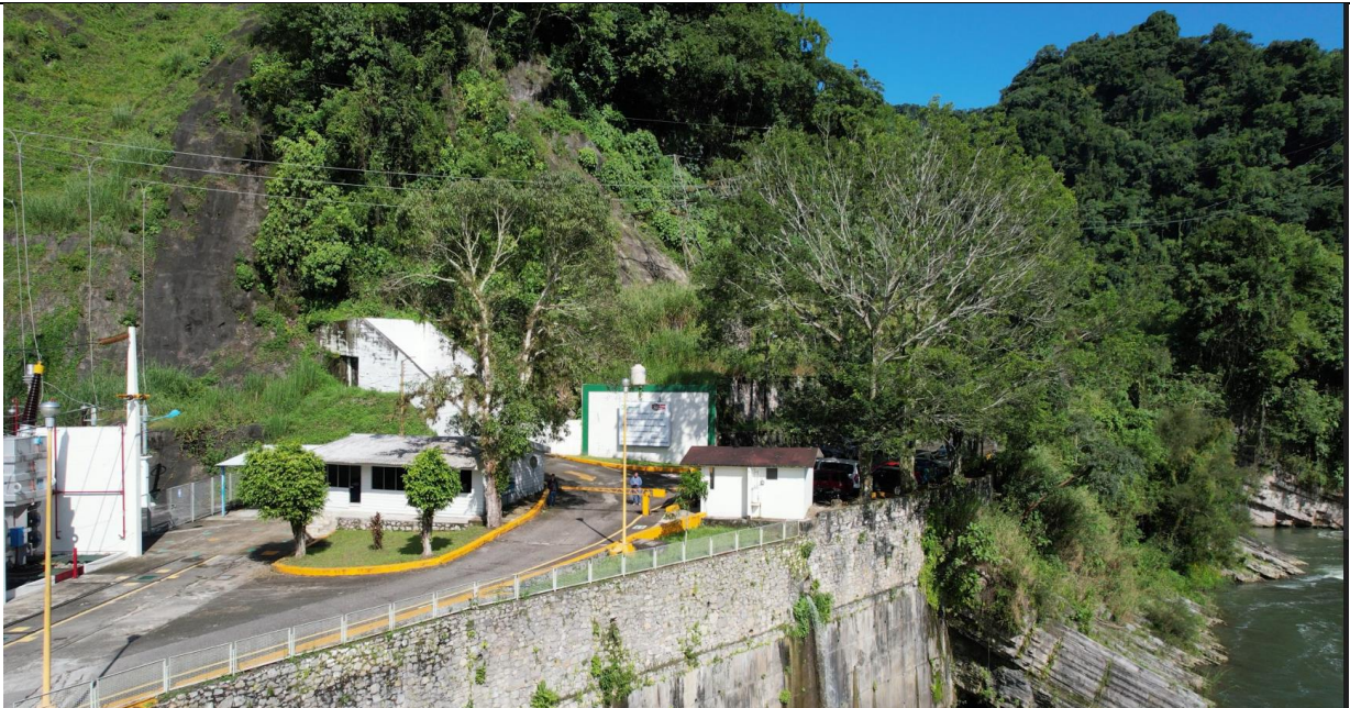
Foto 6. Se ilustra parte de la entrada a la CH Mazatepec.
