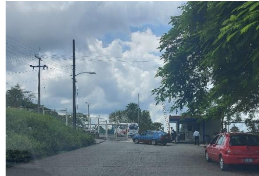
Acceso al campamento de CFE
