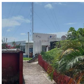
Centro de salud de Mazatepec
