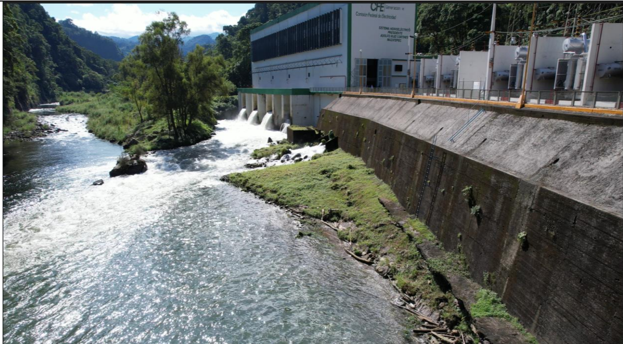
Foto 7. Río Apulco (Tecolutla), se observa la descarga de agua turbinada
