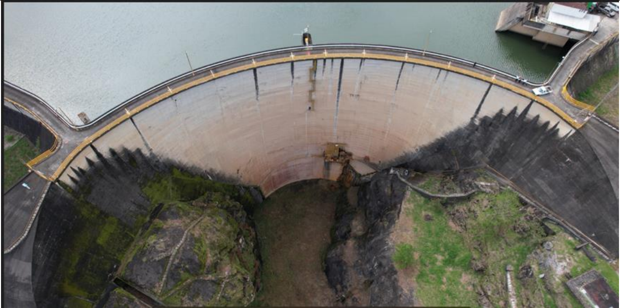
Foto 9. Se ilustra la cortina tipo cúpula de la Presa La Soledad, Puebla.
