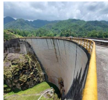
Presa Mazatepec (La Soledad)
