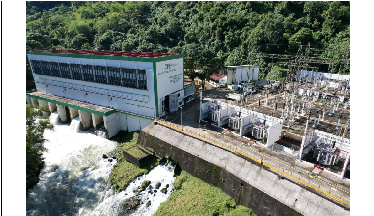
Foto 1. CH Mazatepec, Puebla. Edificio Casa de Máquinas
