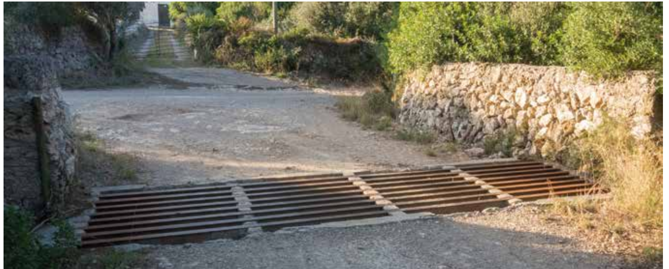
Aspecte d'un pas canadenc instal·lat a l'entrada d'una finca ramadera per evitar la sortida de bestiar.
