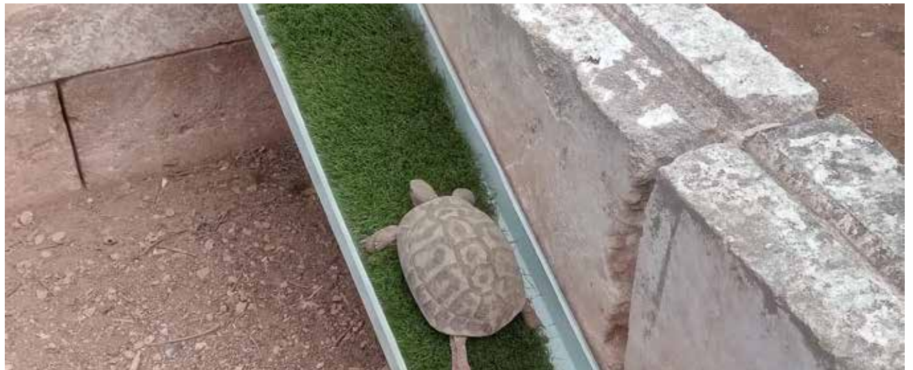
Sistema utilitzat per instal·lar una rampa als passos canadencs perillosos perquè els animals que cauen a l'interior en puguin sortir. És possible instal·lar el sistema amb fortes inclinacions perquè permet l'adherència als animals.
