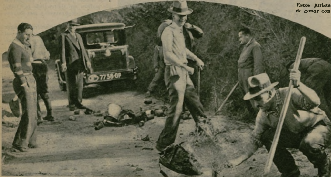
Esta carretera, que aparece en muy mal estado, la van a arreglar los abogados. Es decir..., aseguran ellos que la van a arreglar (Fotos Trampus)
