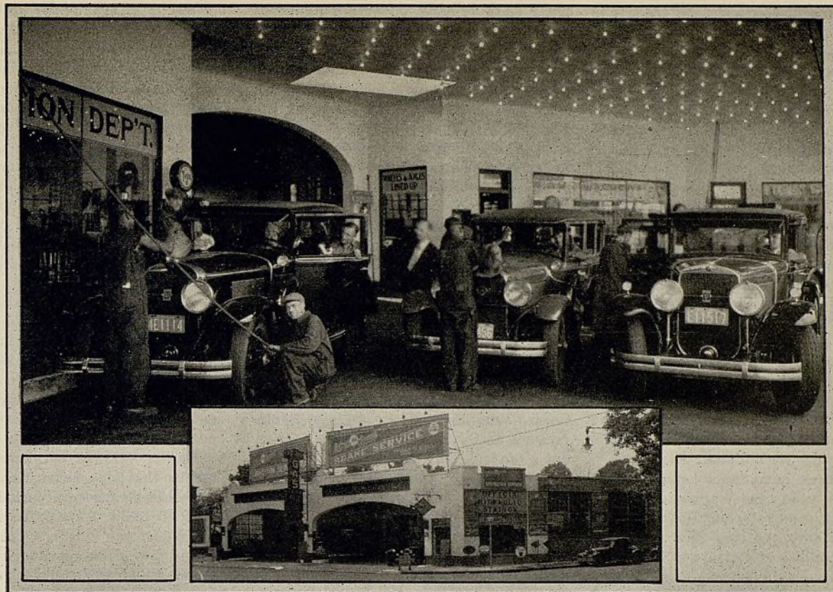
Un buen local para el edificio, inteligente anuncio, amplio alumbrado y completa limpieza, constituyen el secreto del éxito del taller montado a la moderna
