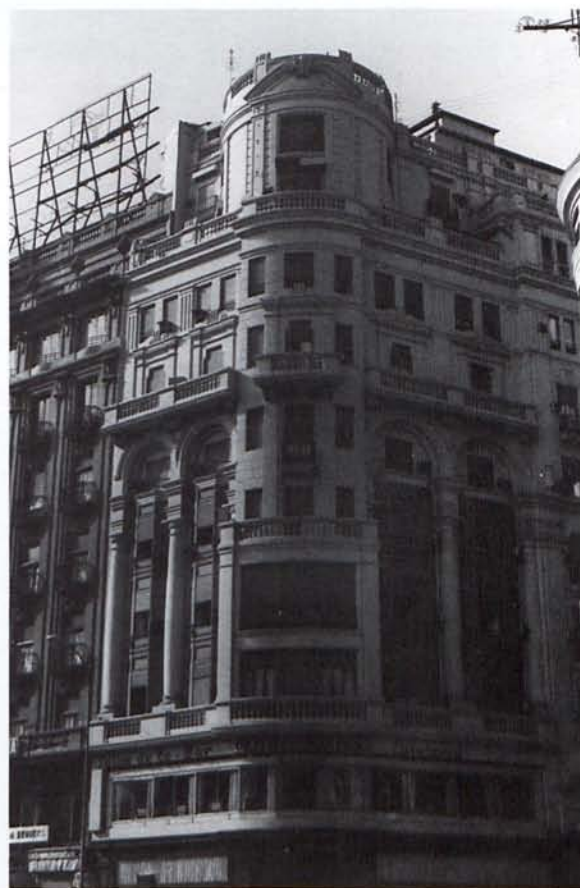
J. Goerlich. Edificio Oltra. Valencia, 1927.
