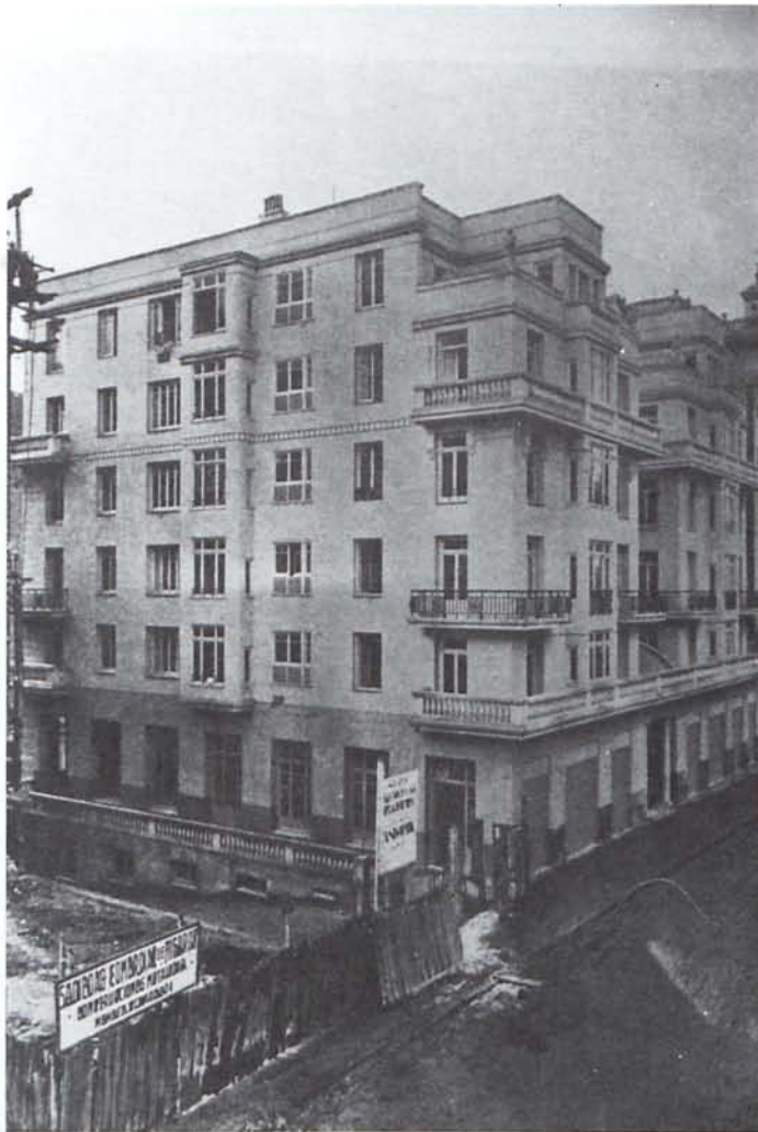
Palacios. Edificio en la calle de Viriato. Madrid, 1923-1926.
