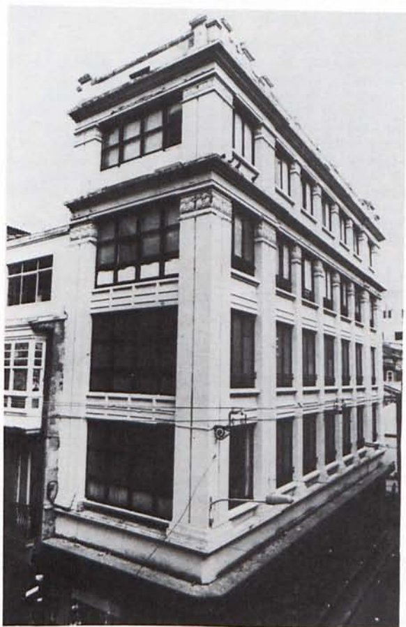
Rodríguez Losada. Edificio comercial en la calle de San Nicolás. La Coruña, 1926.
