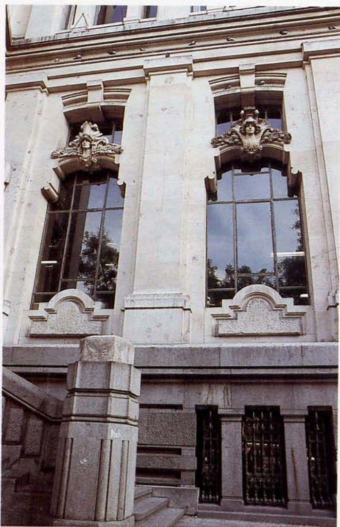
Palacio de Comunicaciones. Madrid. Ventanas y escalera lateral.
