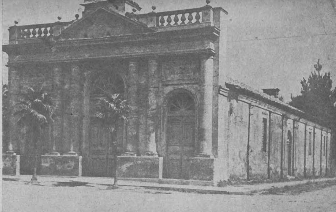
La vieja parroquia de Santa Juana, construida en 1767.
