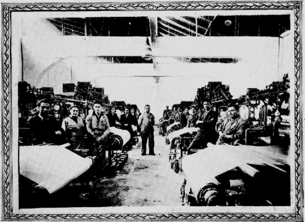
Vista parcial de la Sección Telares.
