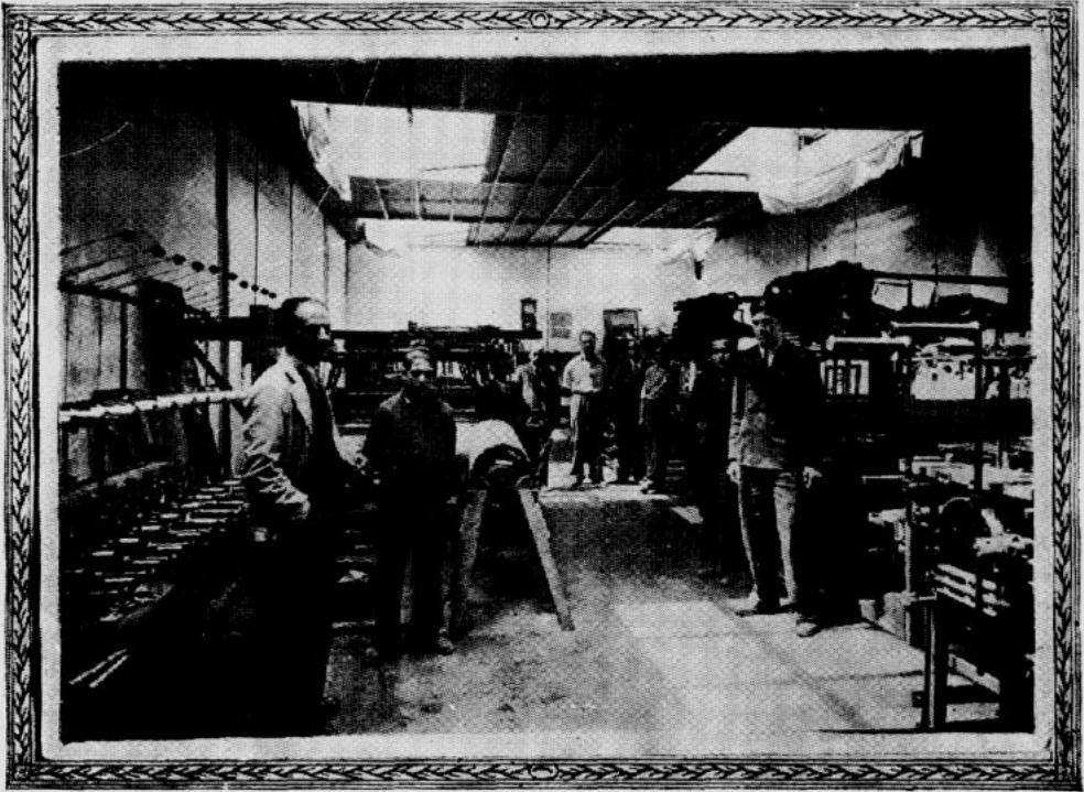
Vista parcial de la sección Telares.
