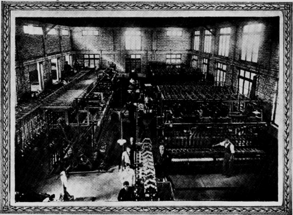
Vista parcial de las Secciones Bobinadoras y Telares.
