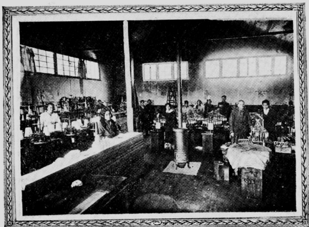
Vista parcial de la Fábrica
