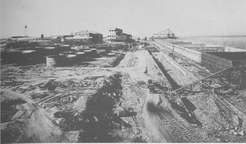
Vista general de la Planta. Oficina Pedro de Valdivia. (1 de marzo de 1931). Archivo arquitecto Sergio Puebla Leeson, Antofagasta.
