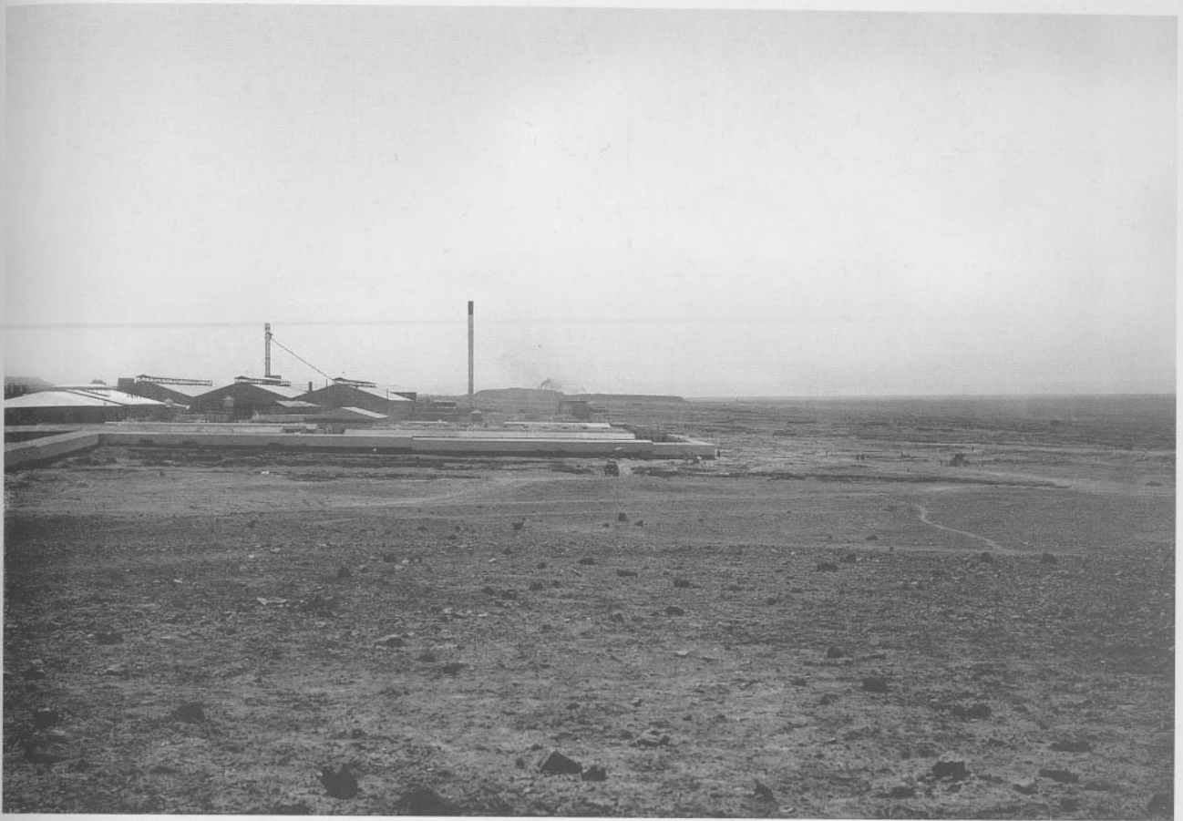
Vista hacia el área industrial. Oficina Chacabuco (1924). Unidad de Biblioteca y Documentación. Sección Archivos Históricos. Universidad Católica del Norte.
