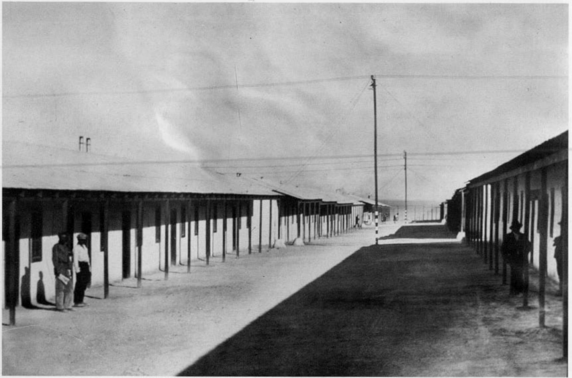
Vivienda del campamento obrero. Oficina Pedro de Valdivia. (15 de julio de 1930). Archivo arquitecto Sergio Puebla Leeson, Antofagasta.
