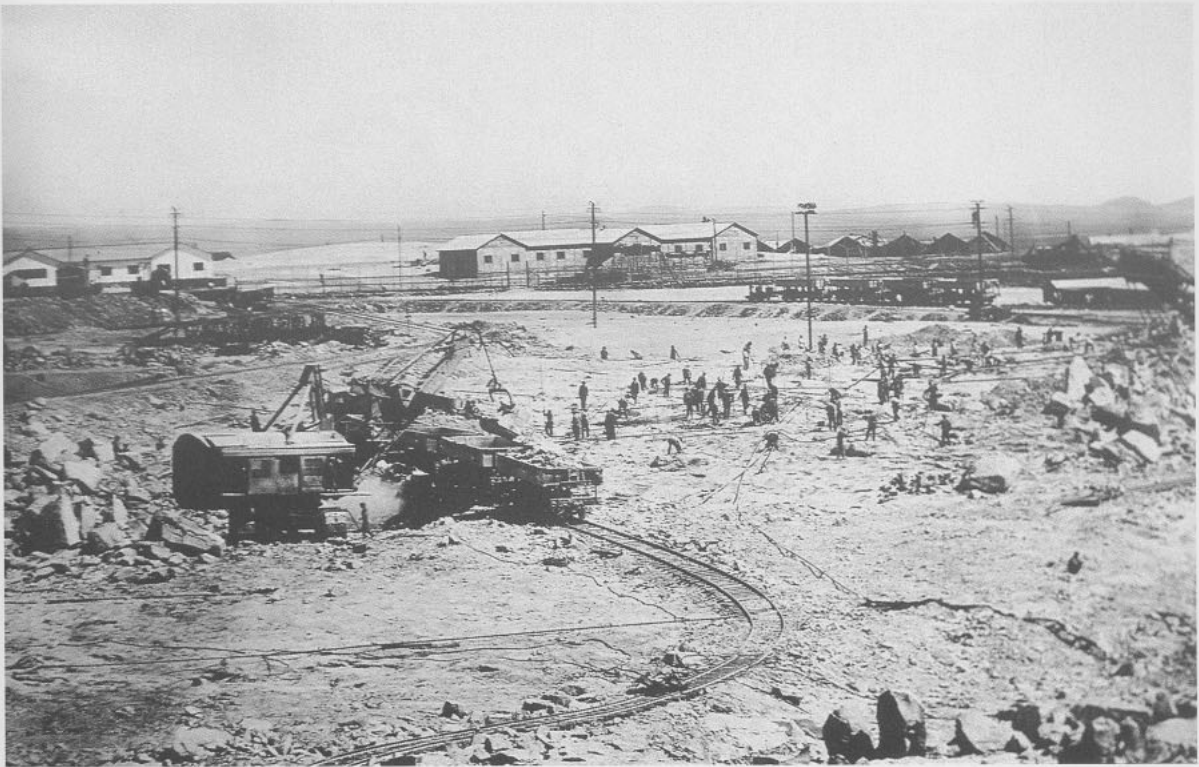
Excavaciones planta industrial. Oficina Pedro de Valdivia. (15 de enero de 1931). Archivo arquitecto Sergio Puebla Leeson, Antofagasta.
