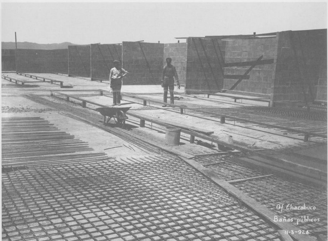
Construcción de Baños Públicos, Oficina Chacabuco (11 de marzo de 1924). Unidad de Biblioteca y Documentación, Sección Archivos Históricos, Universidad Católica del Norte.
