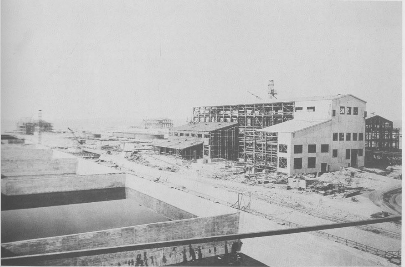
Vista general de la planta Guggenheim. Oficina Pedro de Valdivia. (1 de marzo de 1931). Archivo arquitecto Sergio Puebla Leeson, Antofagasta.
