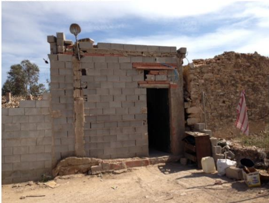
FOTO 5 - ASENTAMIENTO TORRE PACHECO
