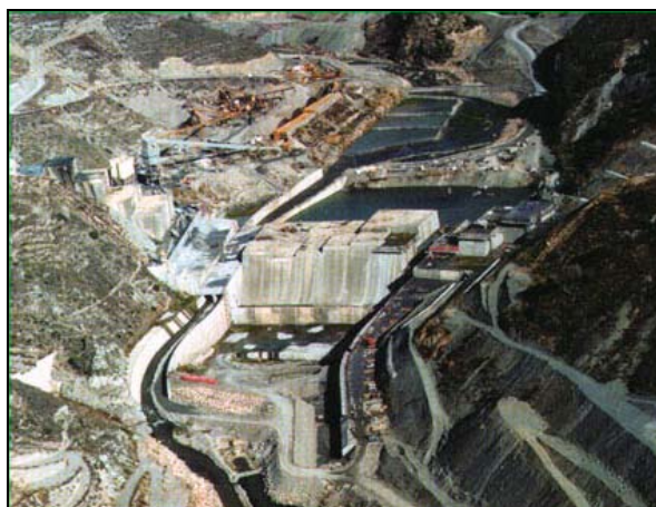
Construcción de una presa
