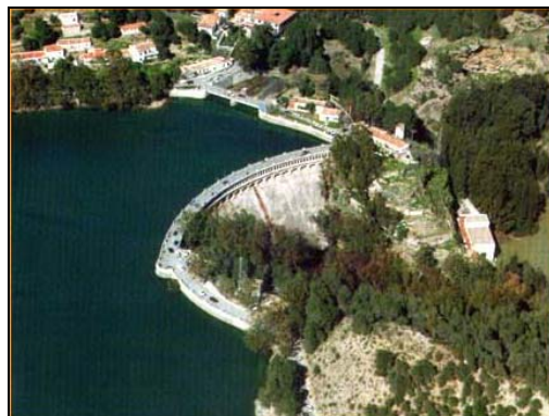
Presa de Conde Guadalhorce
