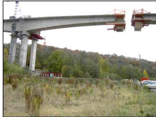
Construcción de puente en voladizo desde pilares
