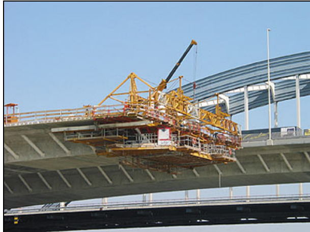
Cimbras de viga en voladizo. Puente sobre el río Lek. Vianen, Países Bajos
