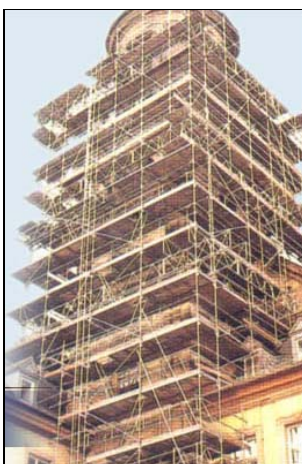
Andamios en edificación
