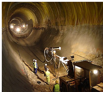
Personal en la obra
