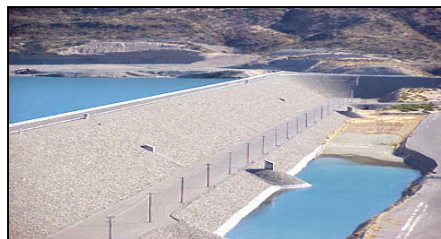
Presa heterogénea de pantalla impermeable
