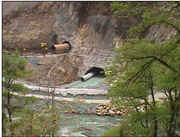
Túnel de desvío de la Presa de Ralco (Chile)
