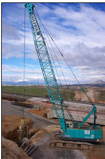
Ejecución de un muro pantalla
