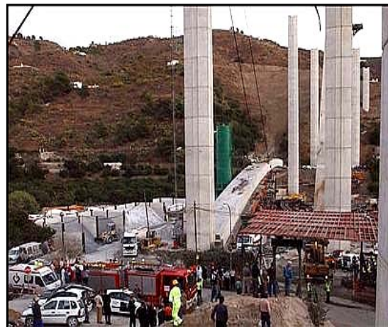
Derrumbe del andamiaje metálico en las obras de la autovía del Mediterráneo en Almuñécar (Granada)
