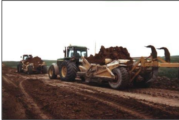
Desbroce del terreno
