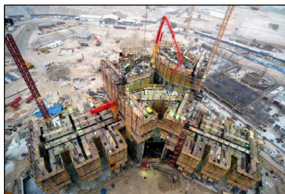
Encofrado de una estructura de hormigón
