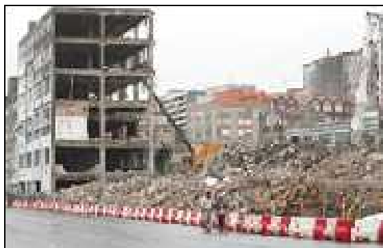
Escombros tras la demolición de un edificio
