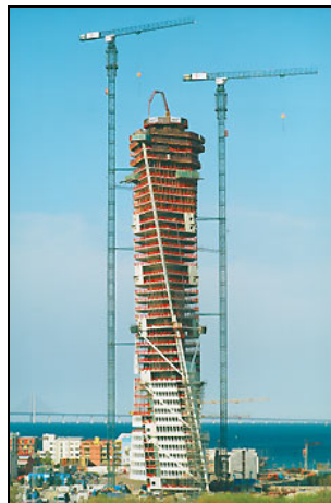
Construcción de un edificio
