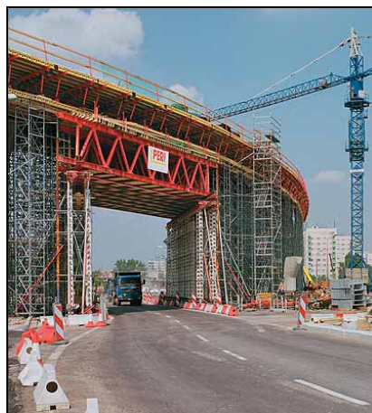
Montaje de cimbra en cruce vial. Czermiakowska, Warschau, Polonia
