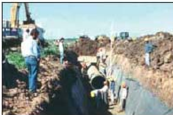
Acumulación de material cercano a la zanja
