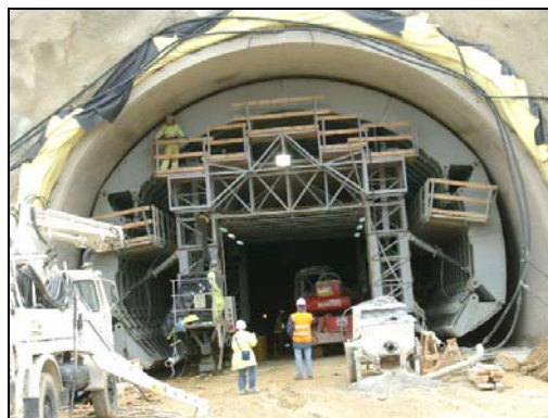
Visita a obra durante la colocación de las dovelas en un túnel
