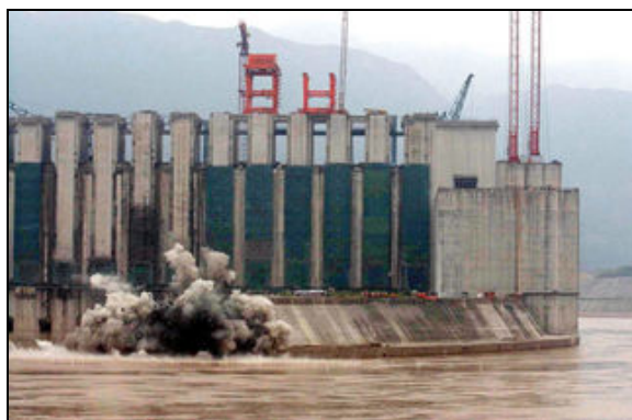
Ataguía de piedra de la Presa de las Tres Gargantas (China)
