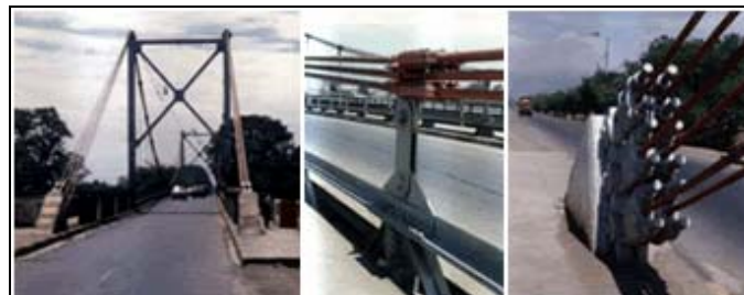
Puente colgante. Detalle de los macizos de anclaje.
