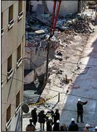
Derrumbe de la línea de metro de El Carmel
