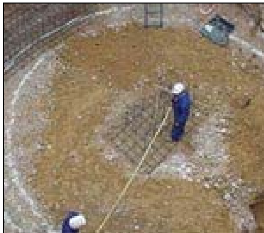
Replanteo de una obra
