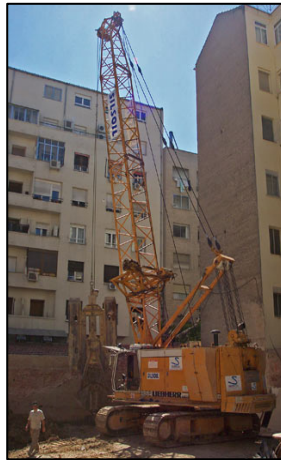
Cuchara bivalva utilizada en la ejecución de un muro pantalla
