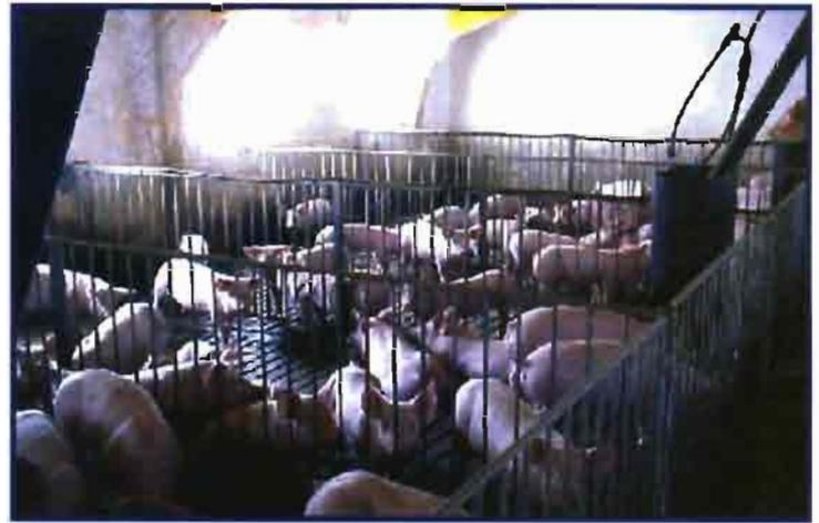
Figura 4.- Divisiones interiores con vallas de acero galvanizado.
