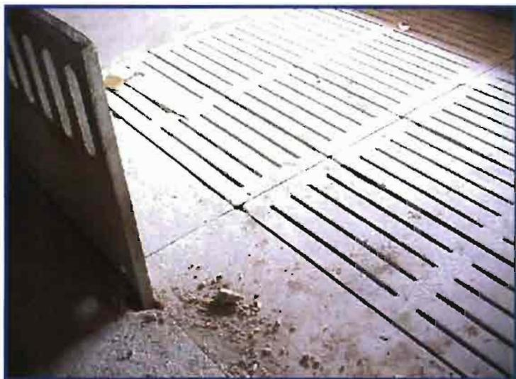
Figura 5.- Suelo enrejillado de hormigón prefabricado.
