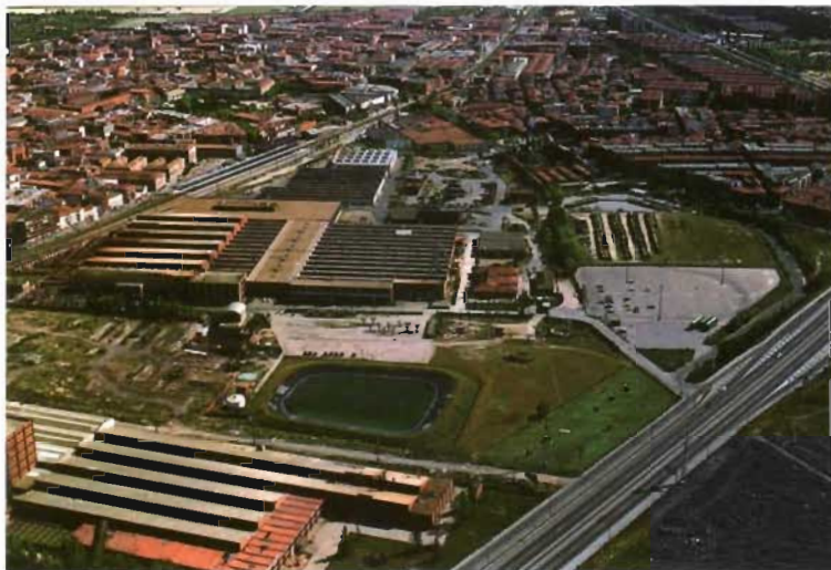
Imagen aérea de las instalaciones de John Deere en Getafe (Madrid).
