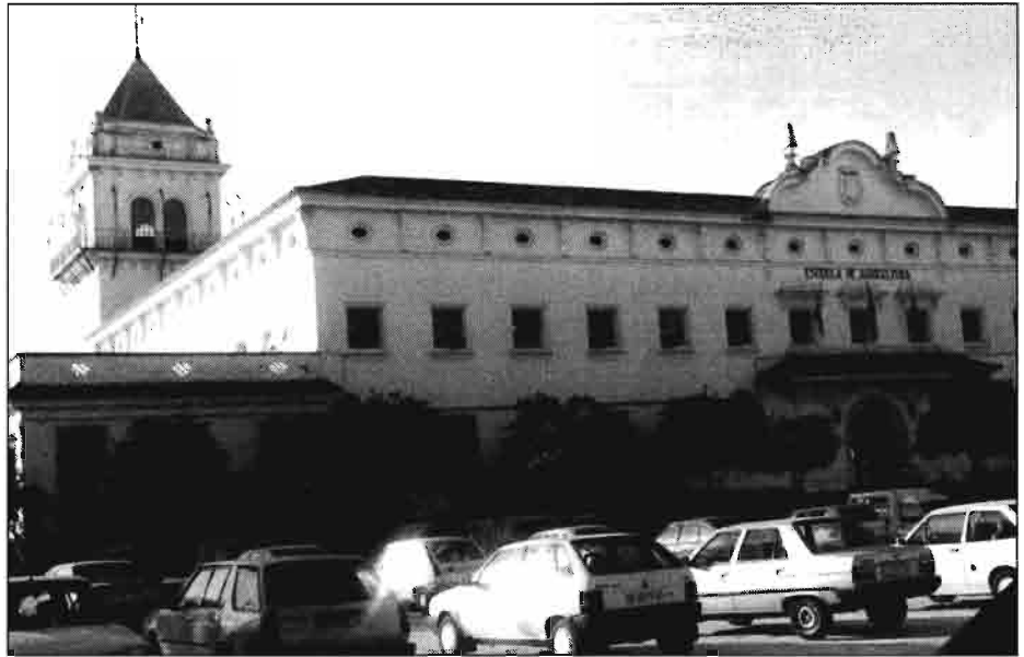
Fachada principal del «Cortijo de Cuarto» y vista de la torre que lo caracteriza. El parking de coches antiguamente era un jardín.
