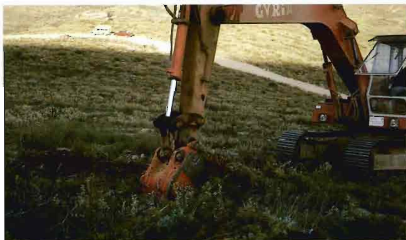
Fig 12. – Ahoyado con retroexcavadora.
