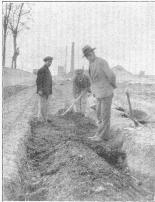
Fig. núm. 1.—Excavada la zanja para el semillero, que tendrá una profundidad variable, y una anchura máxima de 1.50 metros, se amontona a lo largo de ella el estiércol de la cama, para que inicie su fermentación. Comenzada ésta, se extiende y apisona, poniendo encima las capas de tierra y de mantillo, que habrá de quedar con la superficie bien horizontal. Después, se riega para que se asiente, y en seguida puede realizarse su desinfección y siembra.
